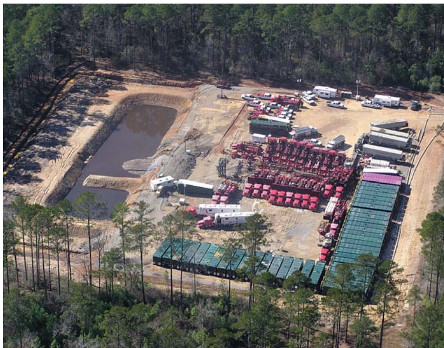
Obr. 1 – Letecký snímek hydraulické injektáže v USA, která trvá cca jeden maximálně dva týdny
