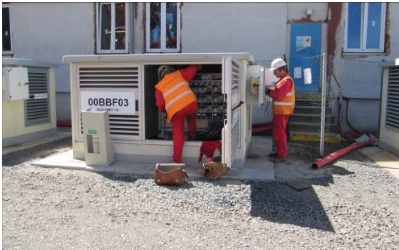
Montáž kiosků v areálu elektrárny
