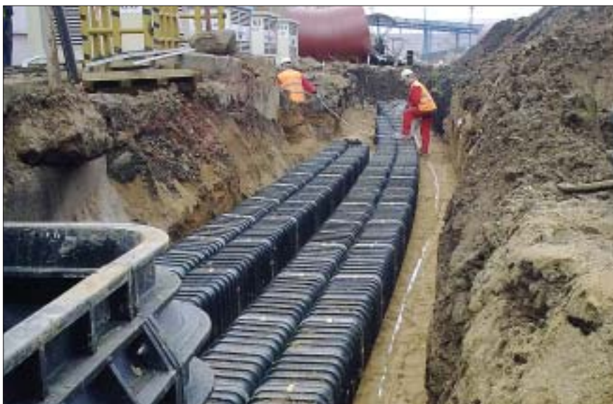
Montáž kabelovodů pro provizoria Elektrárny Ledvice
