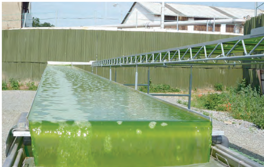
Obr. 5 – Detail instalovaného fotobioreaktoru
