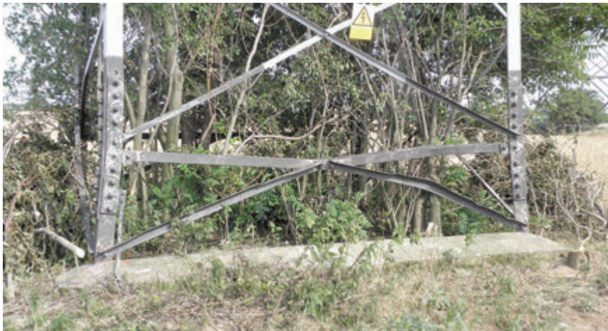
Názorom zdeformovaný rohový uholník a naviazané diagonály v blízkosti votknutia do základu
