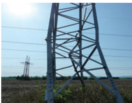
Ťažko narušená statika stožiaru stratou imperfekcie rohových uholníkov a veľkého množstva diagonál
