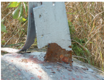
Detail ohnutého rohového uholníka nad rozhraním základu
