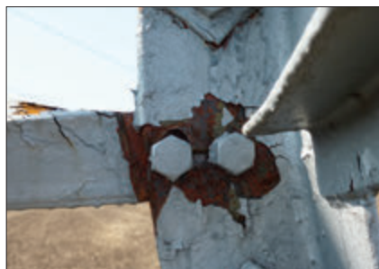
Rovina pretrhnutia steny rohového uholníka v mieste ohybu
