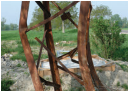
Najčerstvejší príklad poškodenia celozváraného drieku VN stožiara nárazom
