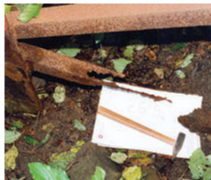
Príklad vyššie popísaných účinkov trvalého vlhka bez ventilácie – 100 % korózný úbytok diagonály 60x60x5 mm
