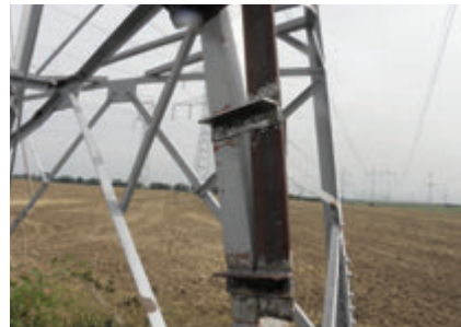
Silové napojenie pre prenos síl
