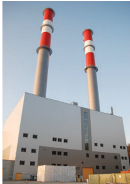
Pohled na hotovou kotelnu zvenku ze strany komínů
