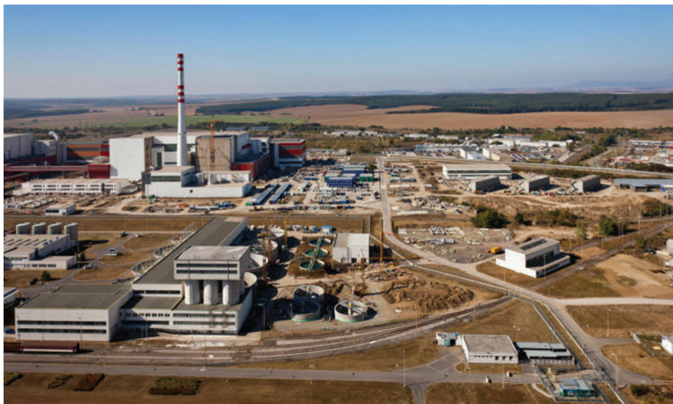
Pohled na staveniště MO34 z východu - ilustrační foto
