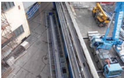
Zahájenie montáže presuvného dopravníka s váhou
