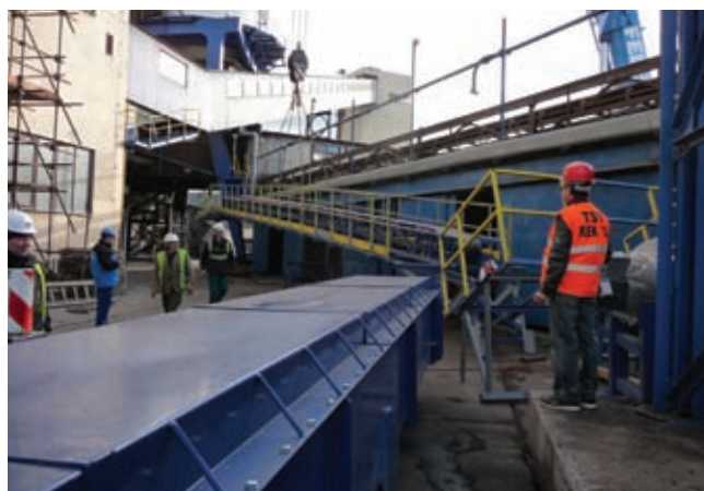
Začiatok montáže presuvného dopravníka s váhou II
