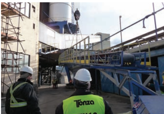
Začiatok montáže presuvného dopravníka s váhou I
