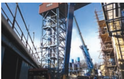
Zdvih reťazového dopravníka druhým žeriavom
