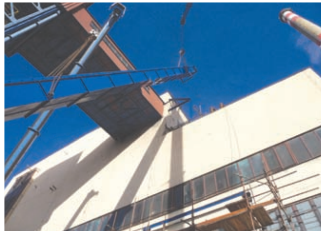
Refazový dopravník sa približuje k miestu montáže zavesený na dvoch výkonných žeriavoch
