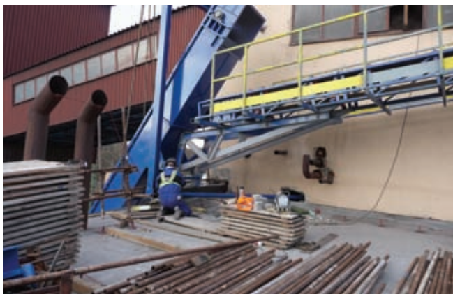
Refazový žeriav sa fixuje na miesto
