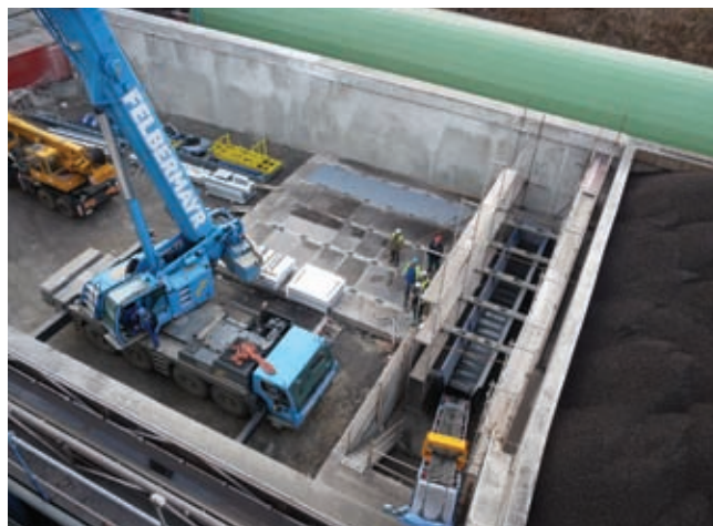
Pohľad na klzné podlahy a strojovňu biomasy, pri montáži horných dopravníkov
