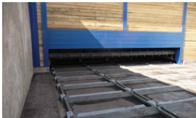
Klzné podlahy pripravené na prevádzku
