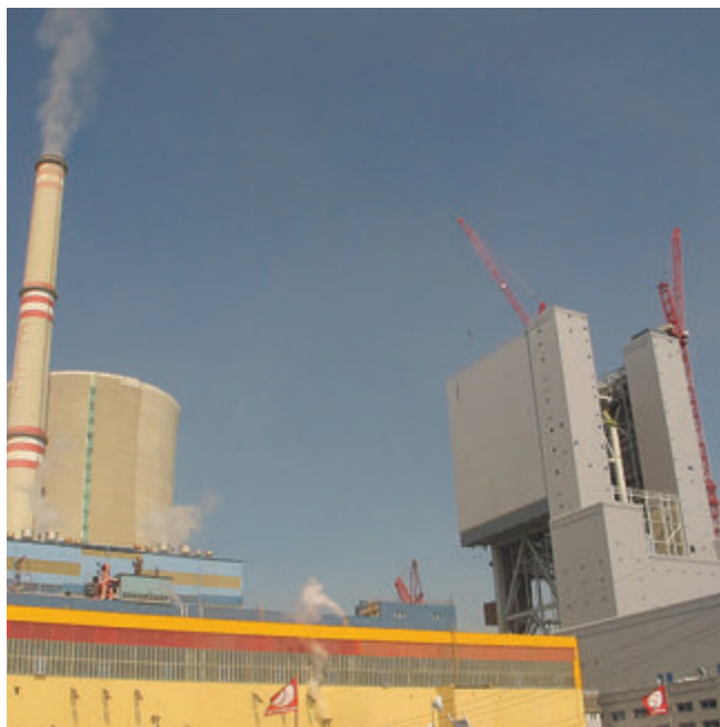
Rozvodna bude sloužit k vývodu Nového zdroje 660 MWe v Ledvicích, vpravo
