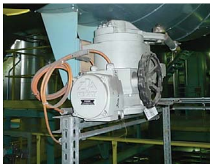
Pákový servomotor MOPED
