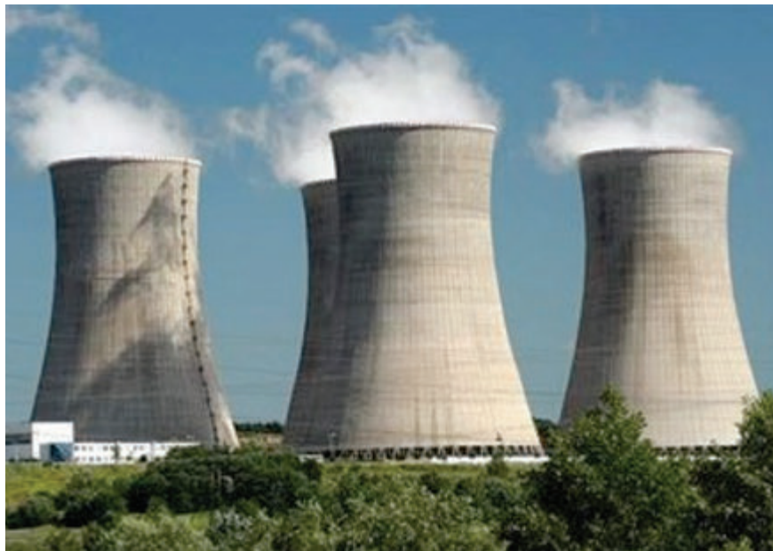
Chladicí věže bloků 1 a 2 Jaderné elektrárny Mochovce
