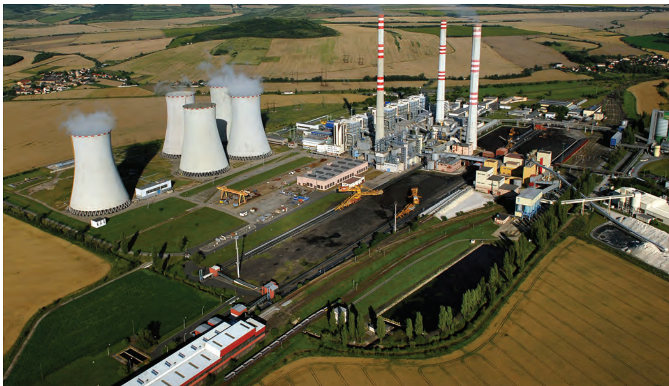
Letecký pohled na Elektrárnu Počerady - prostor pro nový zdroj je vedle stávajících chladicích věží
