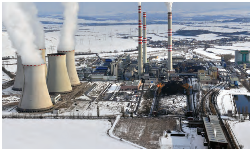
Celkový pohled na Elektrárnu Počerady
