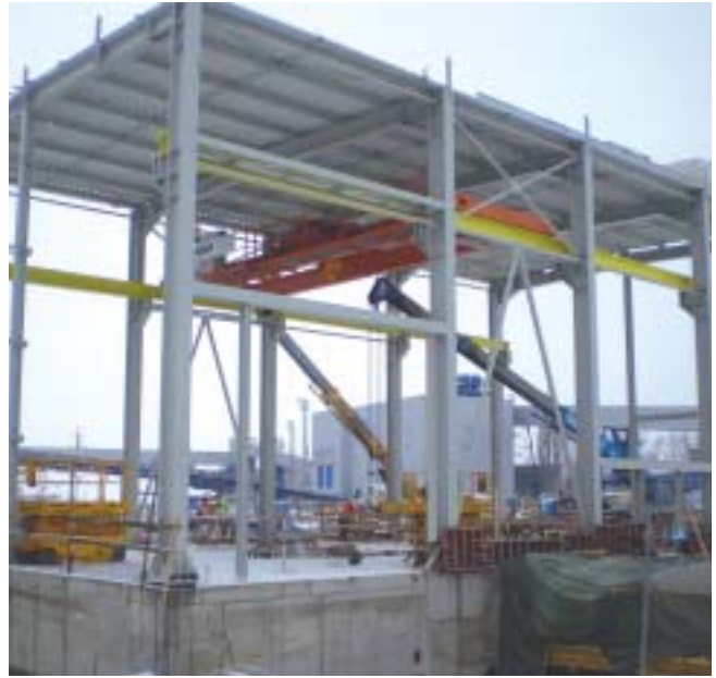
Montáž ocelových konstrukcí (OB16)
