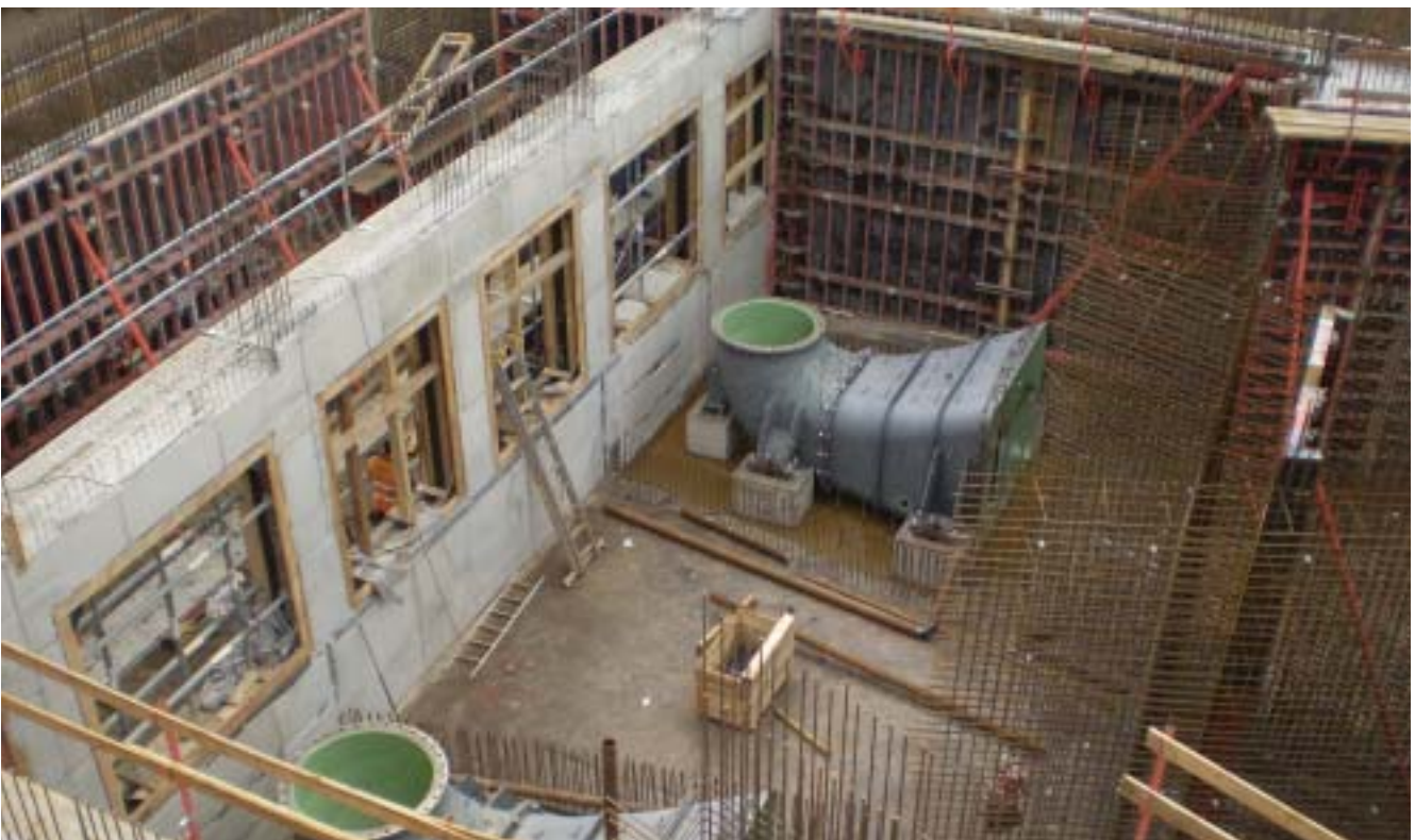
Pohled na staveniště
