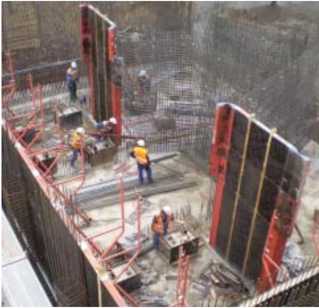
Montáž bednění (OB16)
