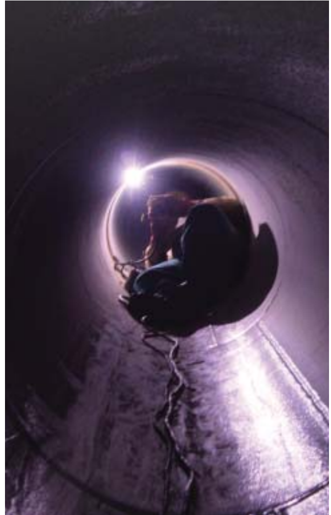
Svařování potrubí v rámci OB51
