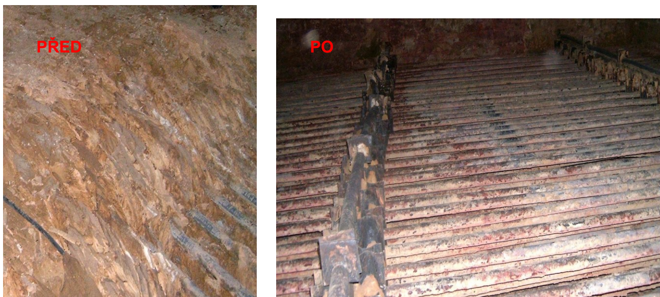
Obr. 6 Zanesení výhřevných ploch vstupu konvektivního přehříváku (KPP)
