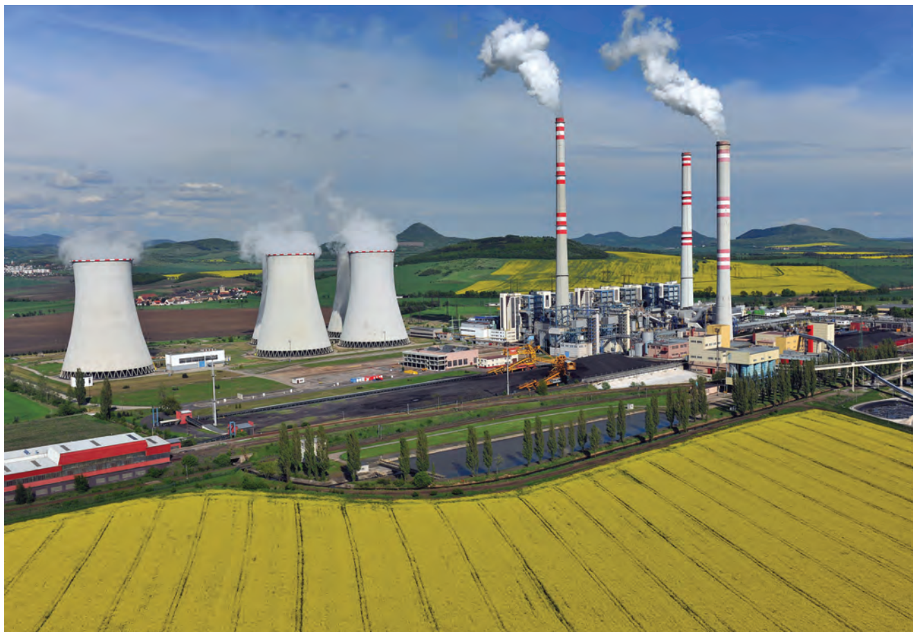
Celkový pohled na elektrárnu - ilustrační foto
