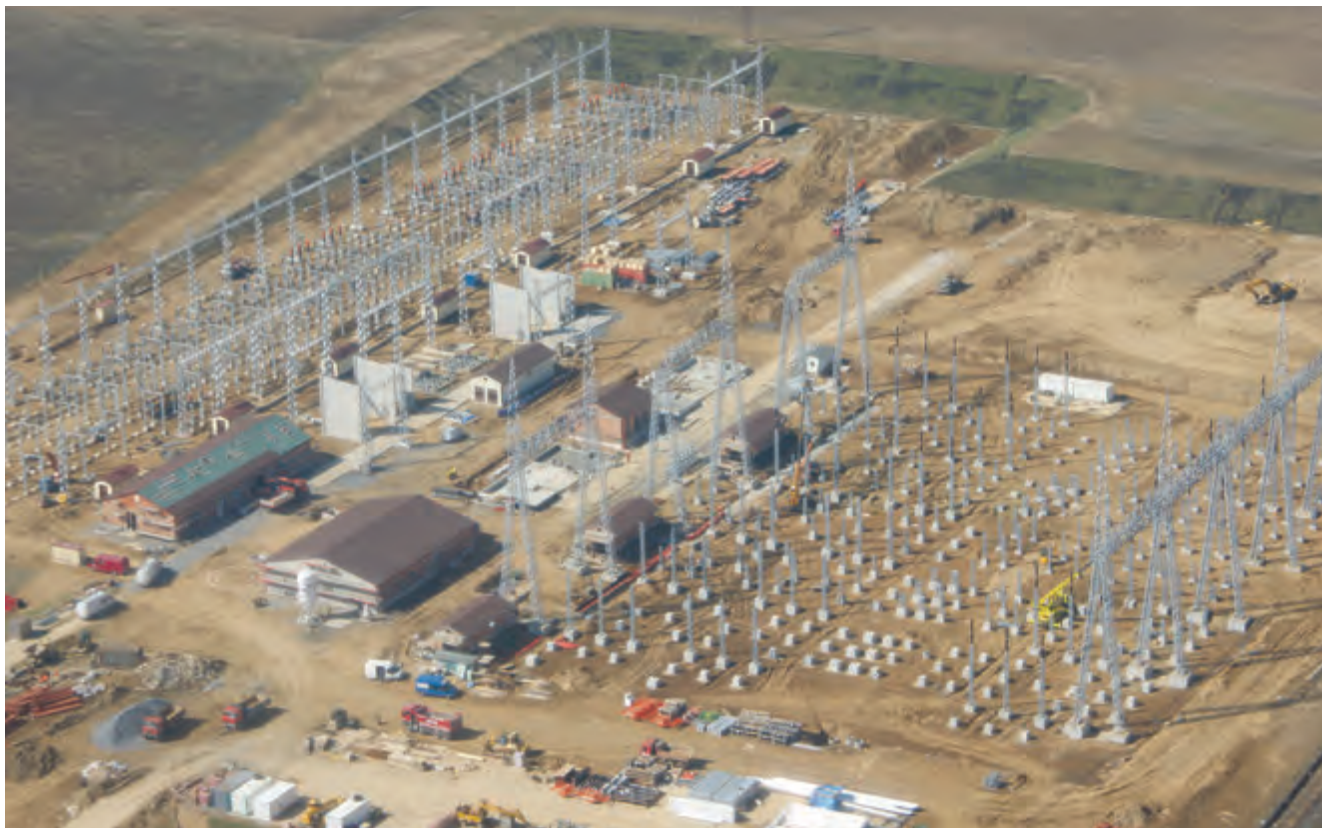
Celkový pohled na staveniště transformovny
