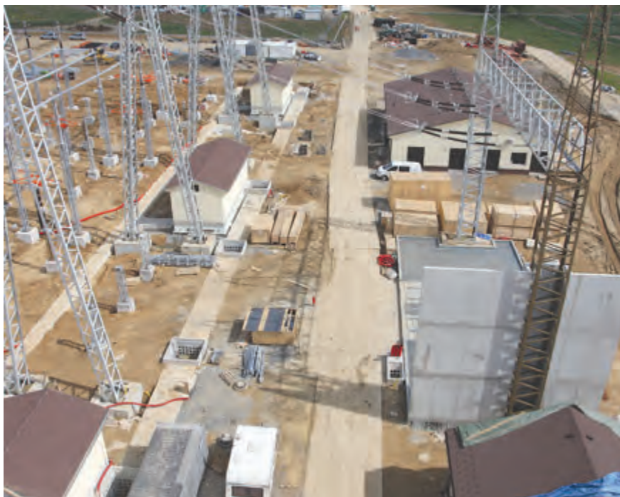
Aktuální situace na staveništi (červenec/srpen 2011)
