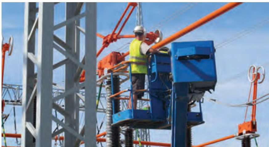
Práce na zprovoznění transformovny v Kletné finišují
