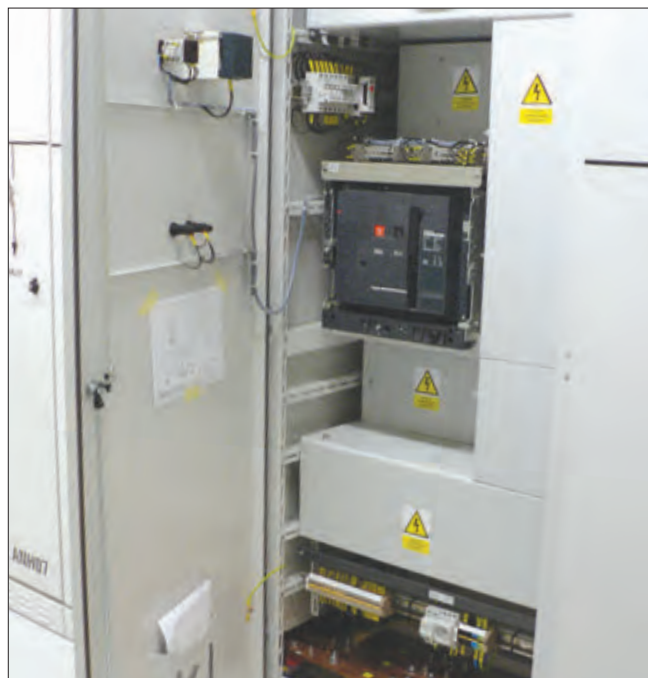
Přívodní pole rozvaděče ANH s výsuvným provedením vzduchového jističe a vysokým zakrytím
