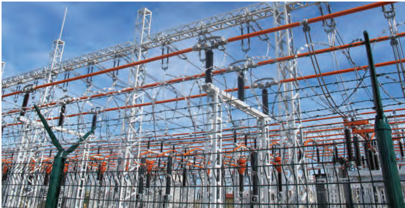
Výstavba nového napájecího uzlu zajistí možnost připojování standardních požadavků investorů a drobných žadatelů
