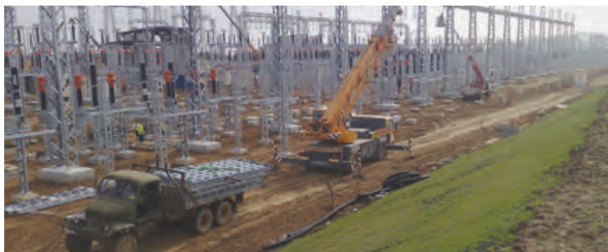
Snímek situace na staveništi
