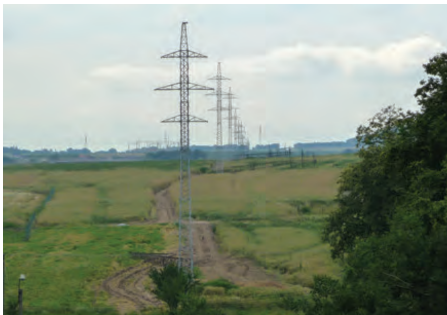
Výstavba nového vyvedení
