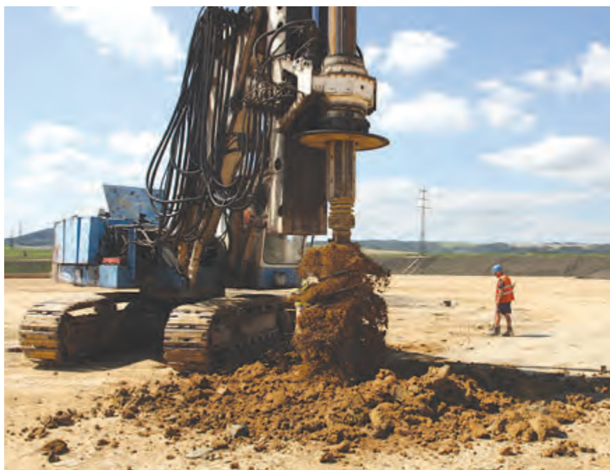
Piloty se vrtaly do hloubky až 12 metrů
