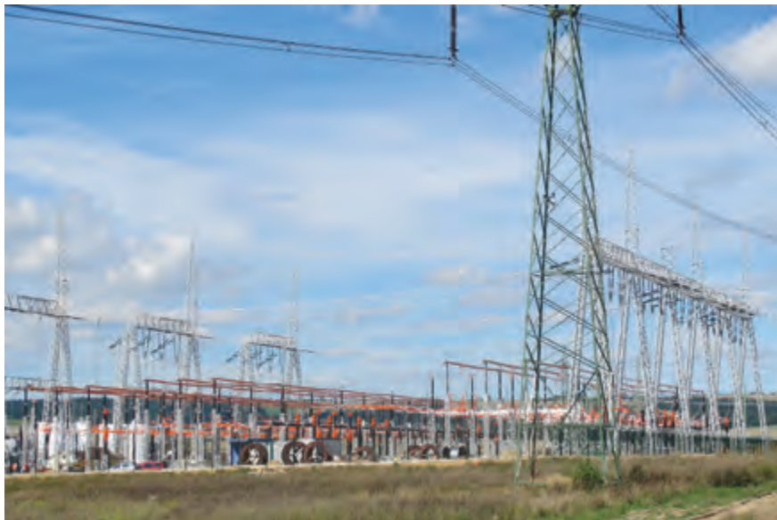
Výstavba nové transformovny šla snadněji, než je to v případě liniových staveb
