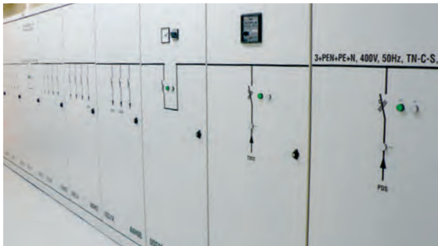
Hlavní rozváděč střídavé vlastní spotřeby (nezajištěné) - ANH
