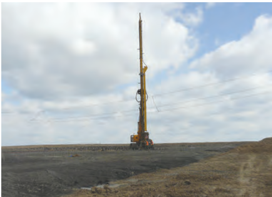
Vrtání základových pilotů
