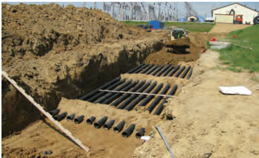
Snímky z přípravy na pokládku rozvodů 22 kV
