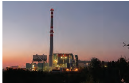
Noční pohled na spalovnu
