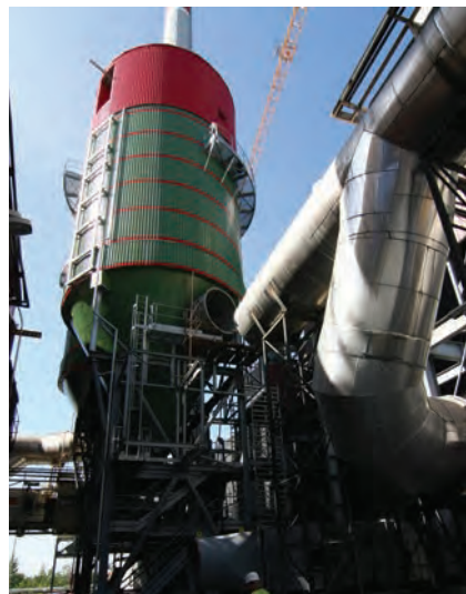
Montáž spalínovodů, v pozadí absorbery
