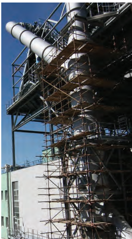
Montáž potrubí ke vzduchovým kondenzátorům
