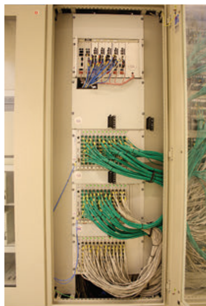
Obr. 2 - Skříň s dvouhodnotovými měřícími ústřednami MOSAD® 5
