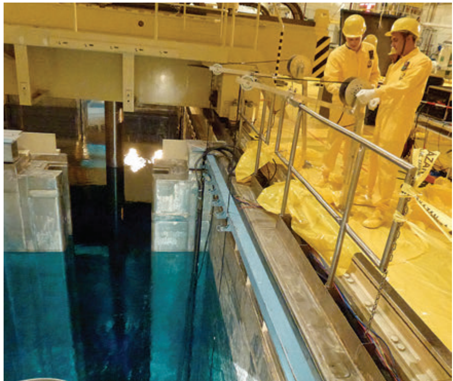
Obr. 12 – Instalace přípravku pro měření rozložení teplot v BSVP
