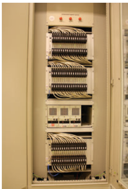
Obr. 1 - Skříň s analogovými měřícími ústřednami MOSAD® 5
