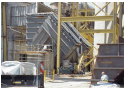
Ukázka instalace oboustranně sacího radiálního ventilátoru
