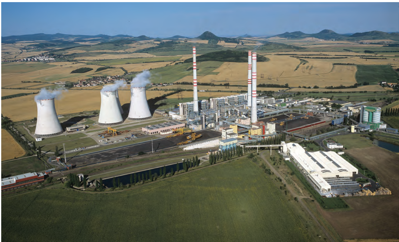
Celkový pohled na Elektrárnu Počerady
