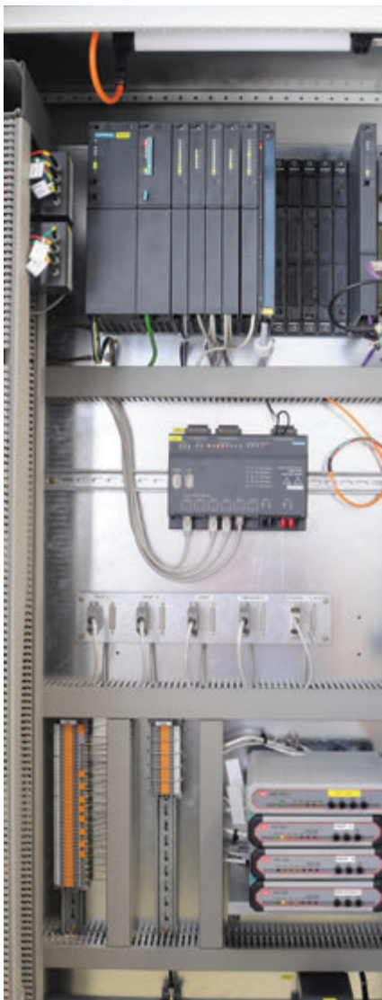
Centrální jednotka původního ŘS SICAM SAS
