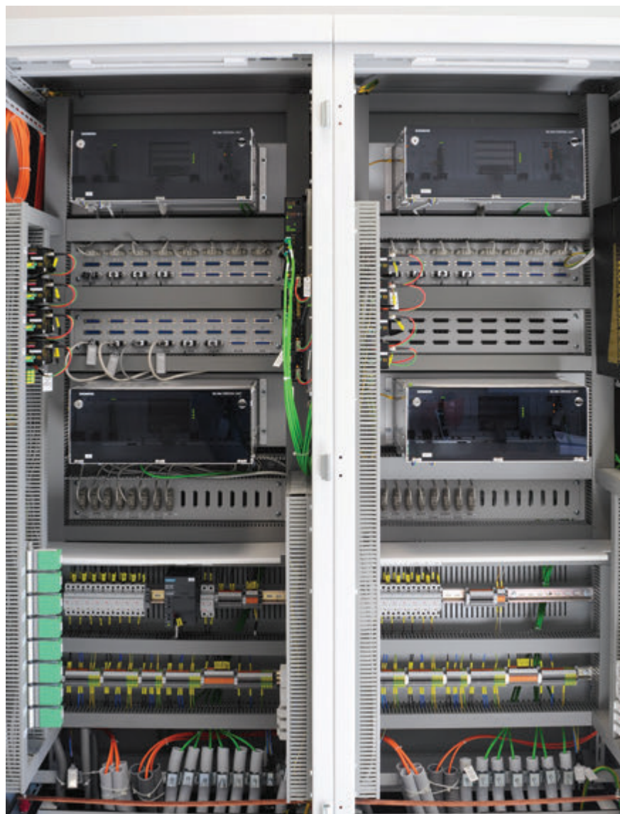
Nový redundantní řídicí systém SICAM PAS
