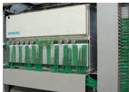
Zadní strana rozváděče s vanou pro moduly FUM a s vnitřním ranžírem Wire-Wrap
