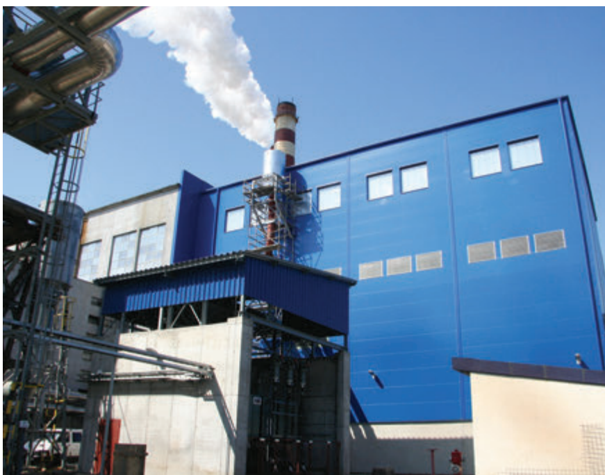
Skutočnosť - pohľad na budovu strojovne a medzistrojovne
