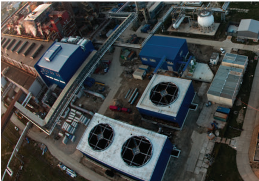
Letecký pohľad na nové celky Teplárne
