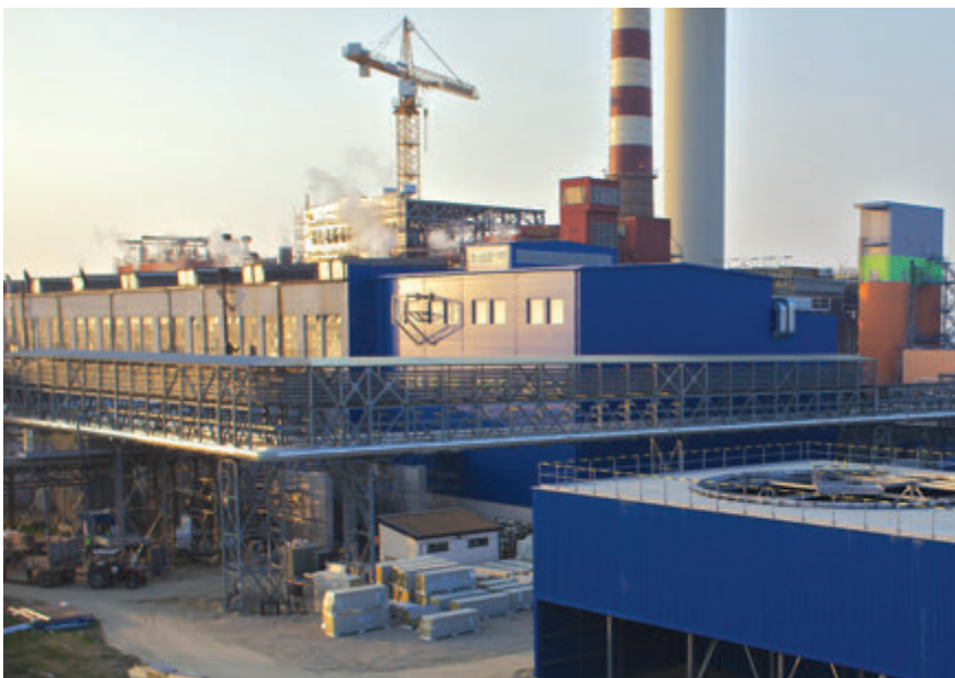
Pohľad na nové celky Teplárne z juhovýchodu
