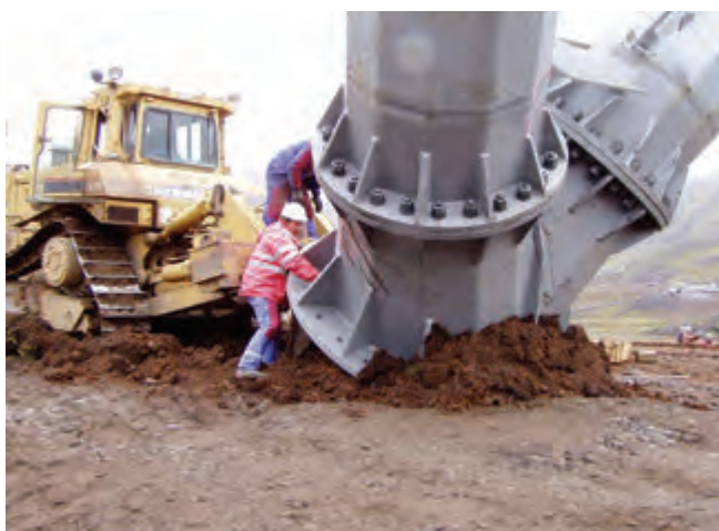
Dokonalý, geometricky veľmi zložitý ale precízne vyhotovený silový uzol
