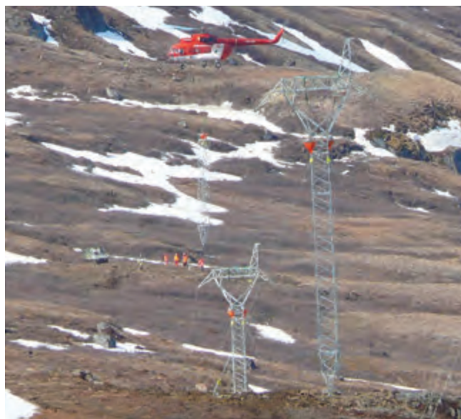
Sériová stavba stožiarov vrtulníkom, pomocou automatických stykových uzlov a delených kotiev
