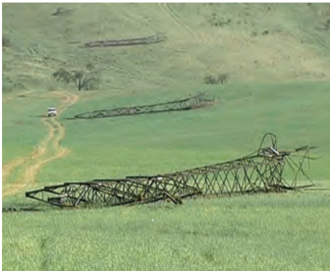
Dôsledky účinkov poryvového vetra. Havarované stožiare po veternej smršti pri Leviciach a Krnove
