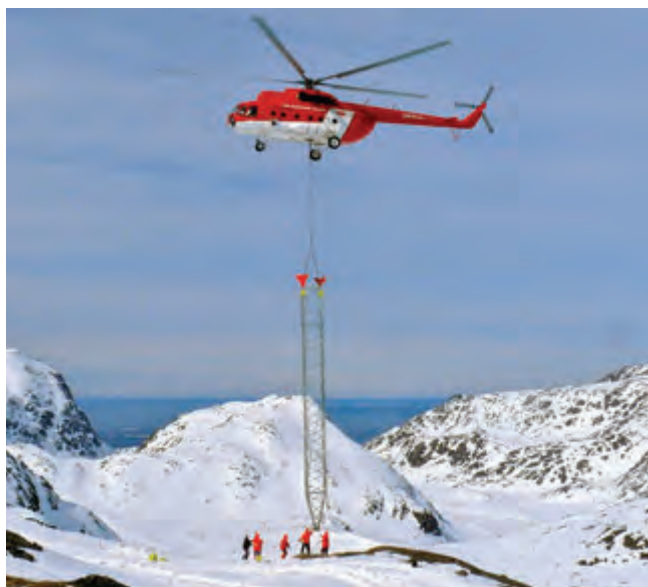
Zúročená detailná príprava a technická podpora výstavby stožiarov
