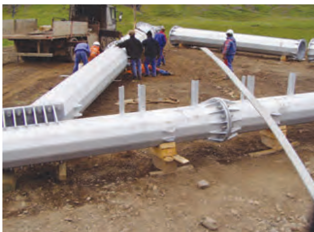
Montáž silového trojuholníka v horizontálnej polohe
