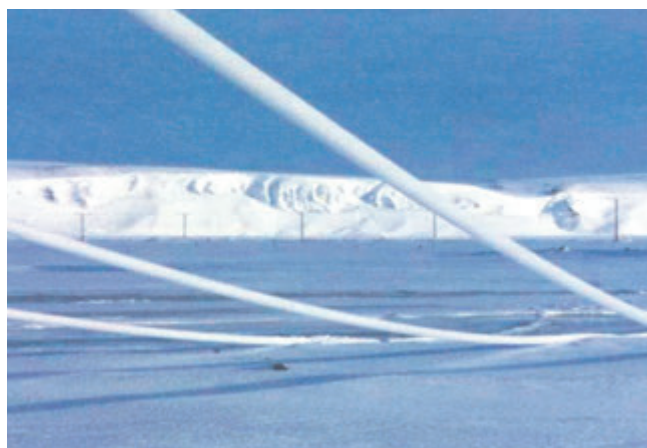
Váha ľadom obalených vodičov pôsobí na konštrukciu imperfekciou profilov už nestabilného stožiaru do úplného kolapsu
