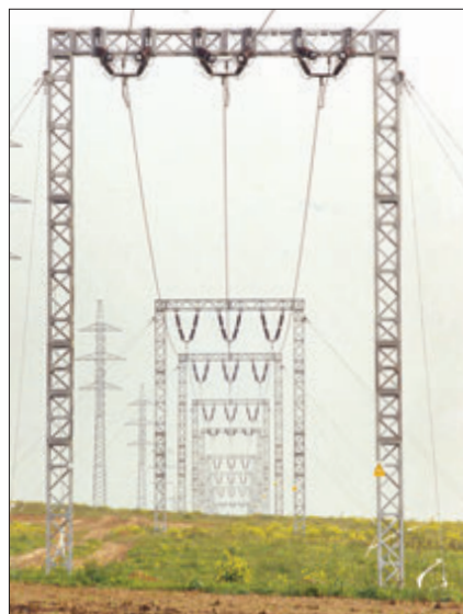
V krátkom čase vybudovaná prenosová cesta 110 kV pre rýchle zásobenie regiónu energiou - bypass
