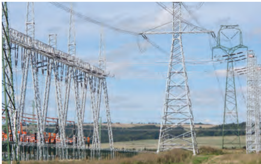
Pohled na místo propojení stávajícího vedení a nové transformovny 400/110 kV Kletné
