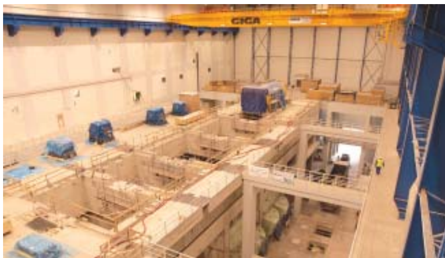
Snímek dokončené stavební připravenosti strojovny (+15,5 m). Dodavateli technologie byla strojovna předána s osazeným generátorem
