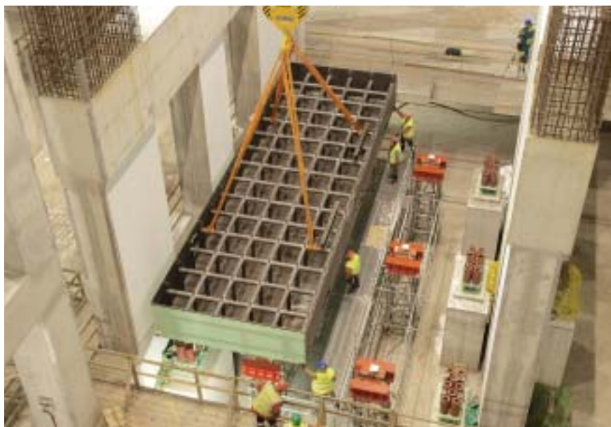
Snímek z usazování poloviny sběrače kondenzátoru na základ s pružinovými podpěrami a podpůrné věže
