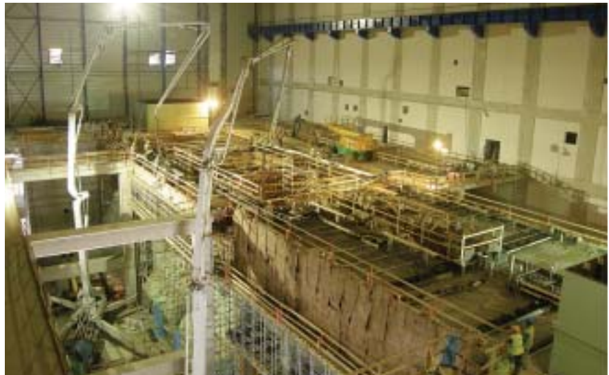
Obrázek průběhu betonáže IV. části TG
