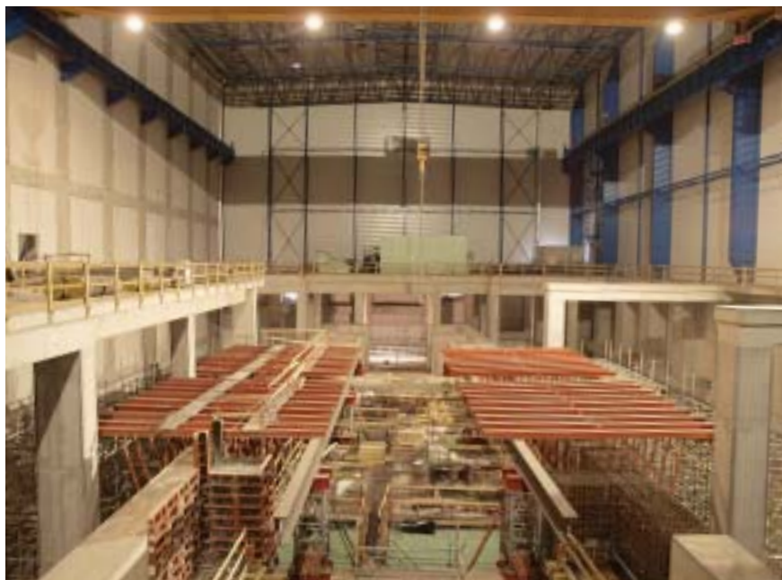
Obrázek zavěšeného bednění při dokončení vynechaných podélníků z důvodů osazování kondenzátorů
