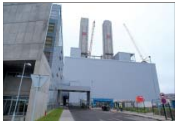
Fotografie postupu opláštění schodišťových věží
