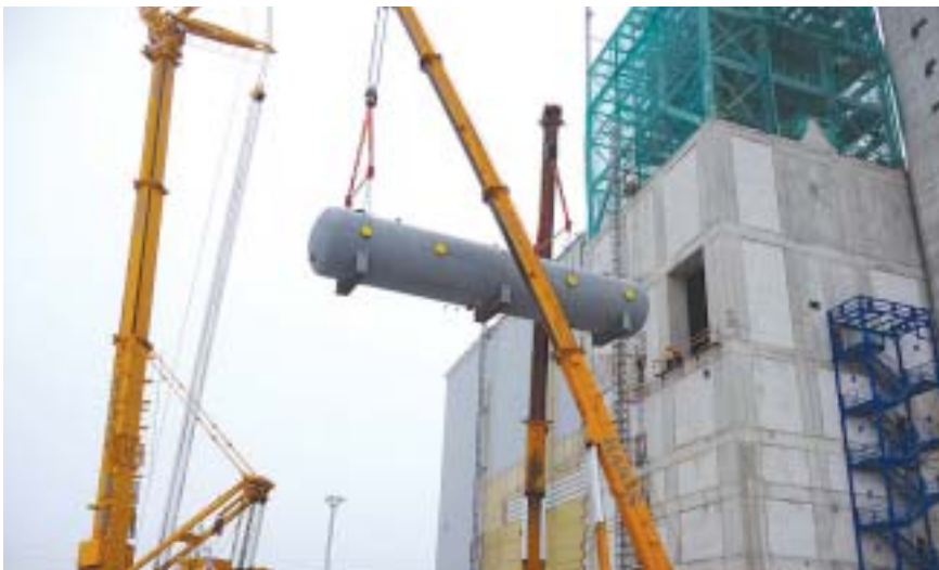
Obrázek zvedání napájecí nádrže dvěma mobilními jeřáby
