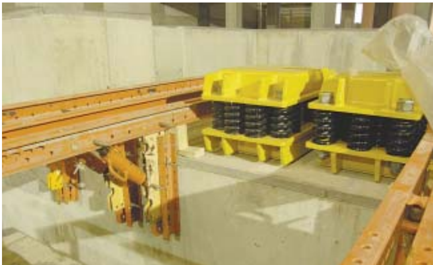
Snímky z osazování pružinových podpěr GERB
