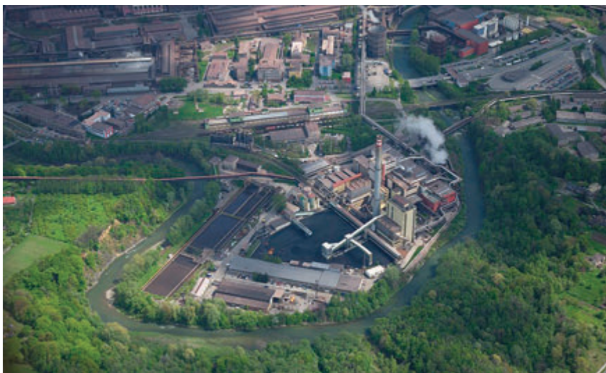
Letecký pohled na teplárnu E3 společnosti Energetika Třinec
