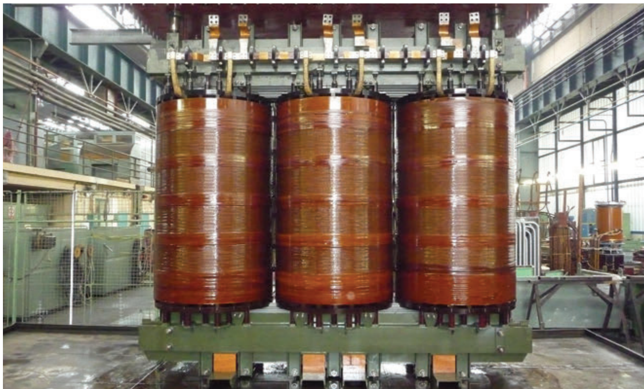
Snímek části transformátoru po opravě
