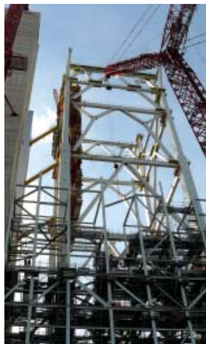
Ocelová konstrukce kotle
