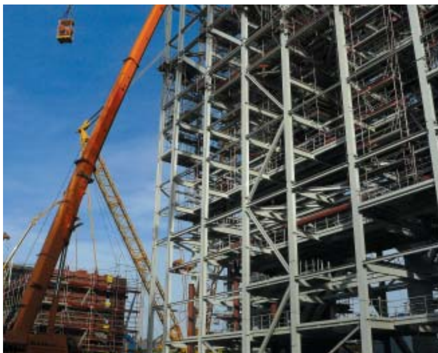
Snímek z montáže ocelové konstrukce kotle
