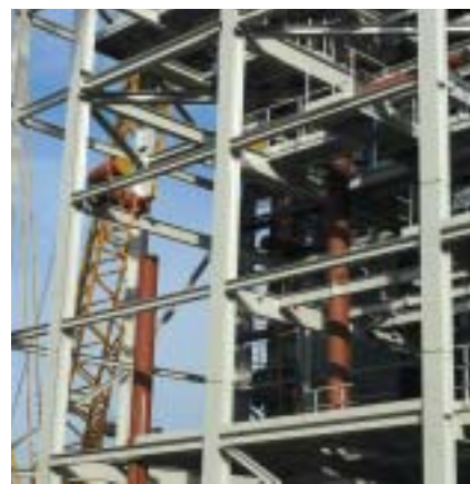
Montáž potrubí v ocelové konstrukci
