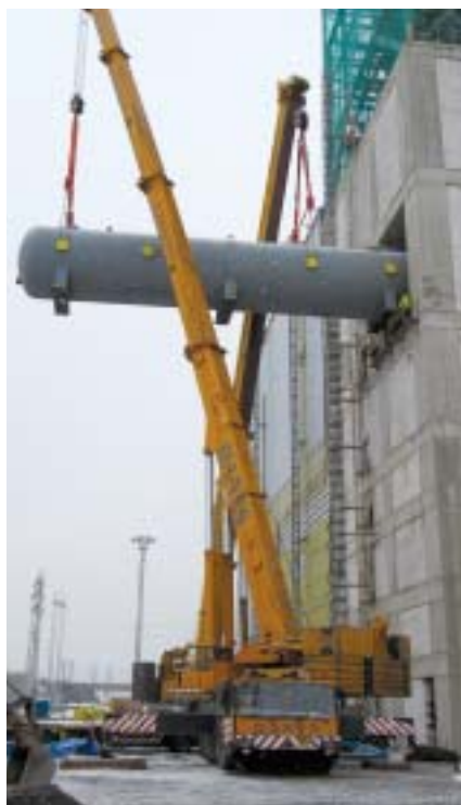
Montáž napájecí nádrže na úrovni + 21,5 m
