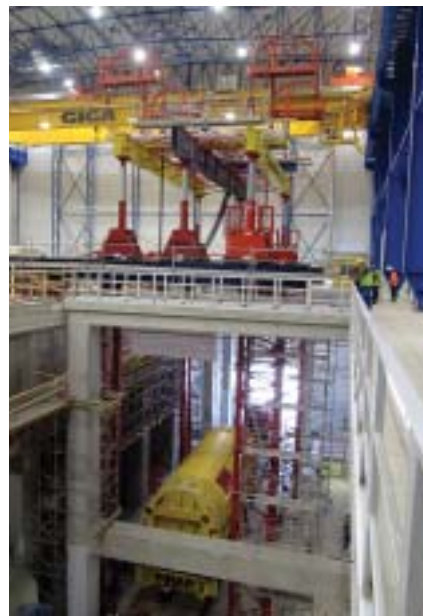
Foto z instalace generátoru do strojovny
