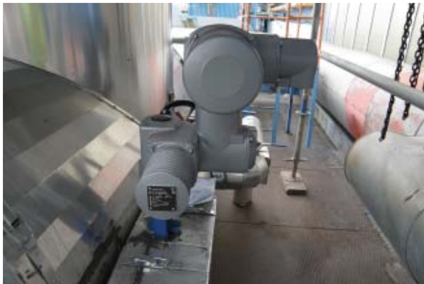
Provedení obtoku a vypouštění sběrnice
