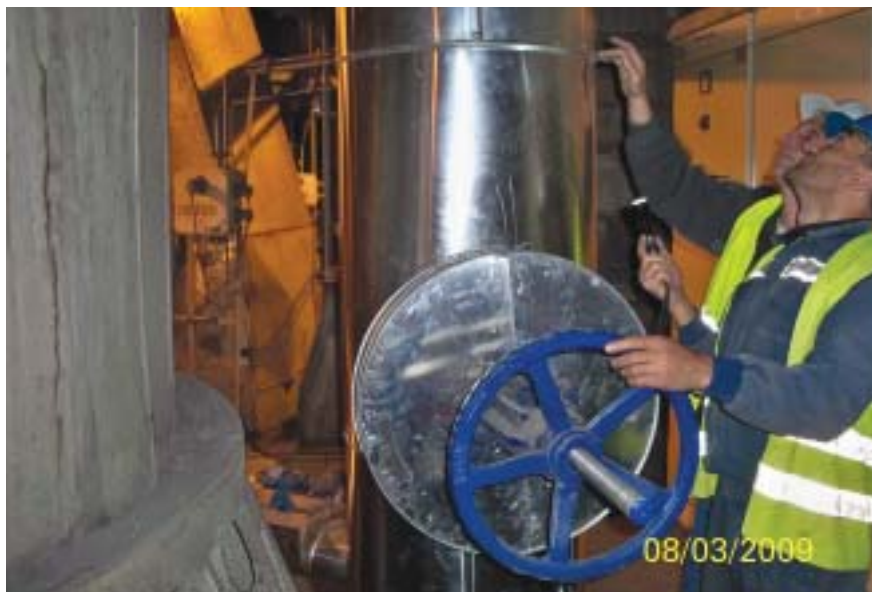
Potrubí cizí páry
