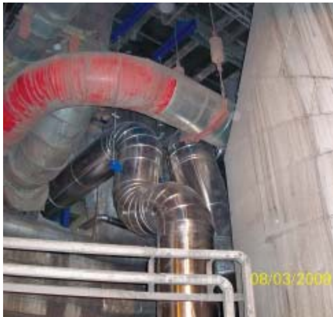
Složité montážní podmínky potrubí cizí páry
