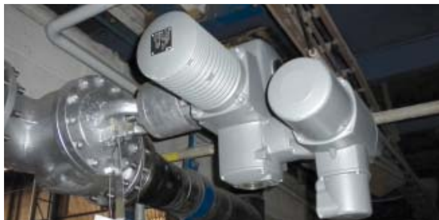
Potrubí a armatura demi vody
