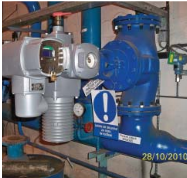
Přípojka v kompresorové stanici
