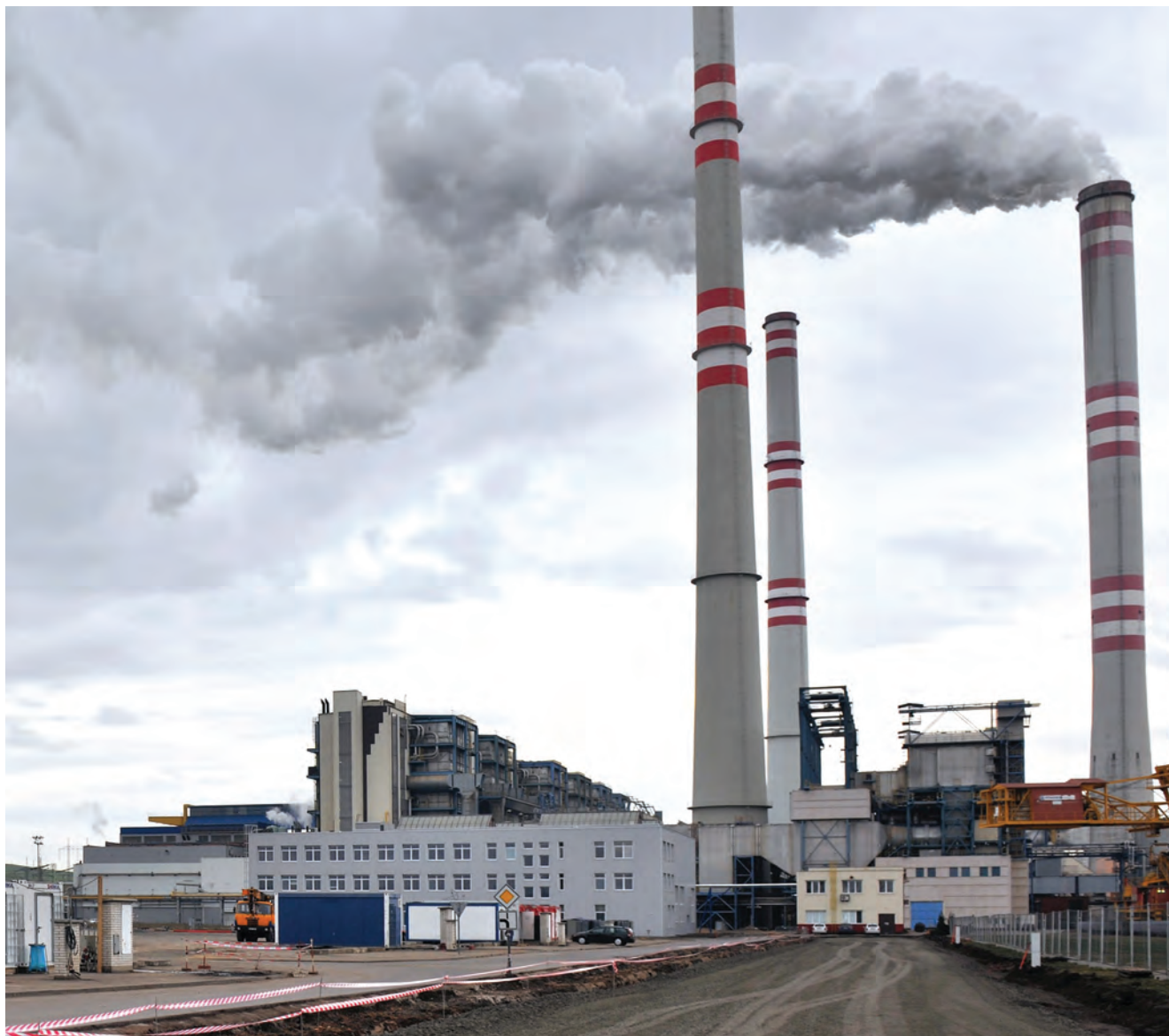
Pohled na Elektrárnu Počerady
