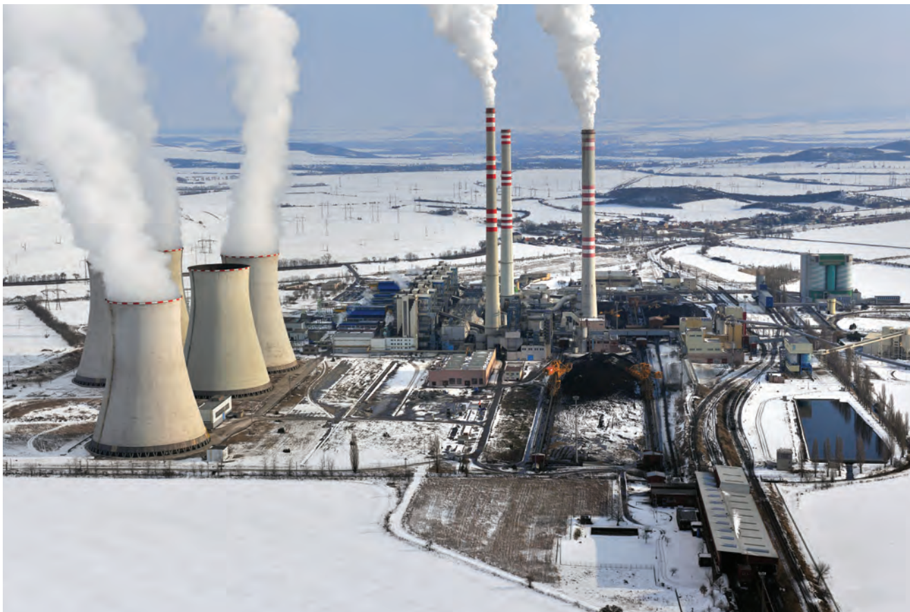
Vedle stávajících chladicích věží je prostor pro nový zdroj
