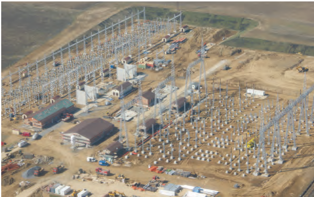
Celkový pohled na staveniště transformovny
