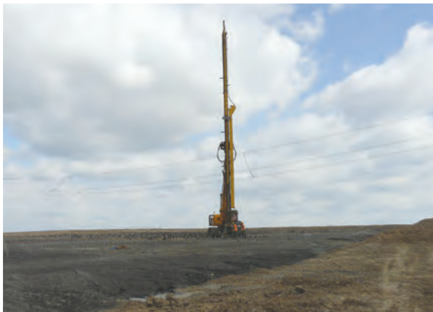
Vrtání základových pilotů
