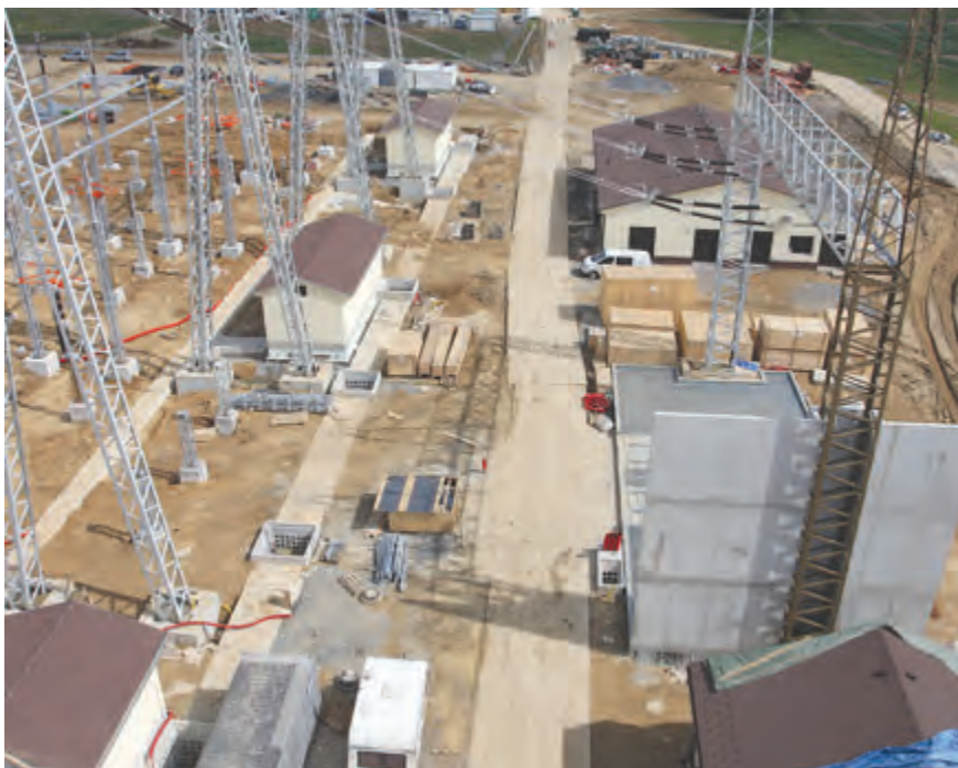
Aktuální situace na staveništi (červenec/srpen 2011)
