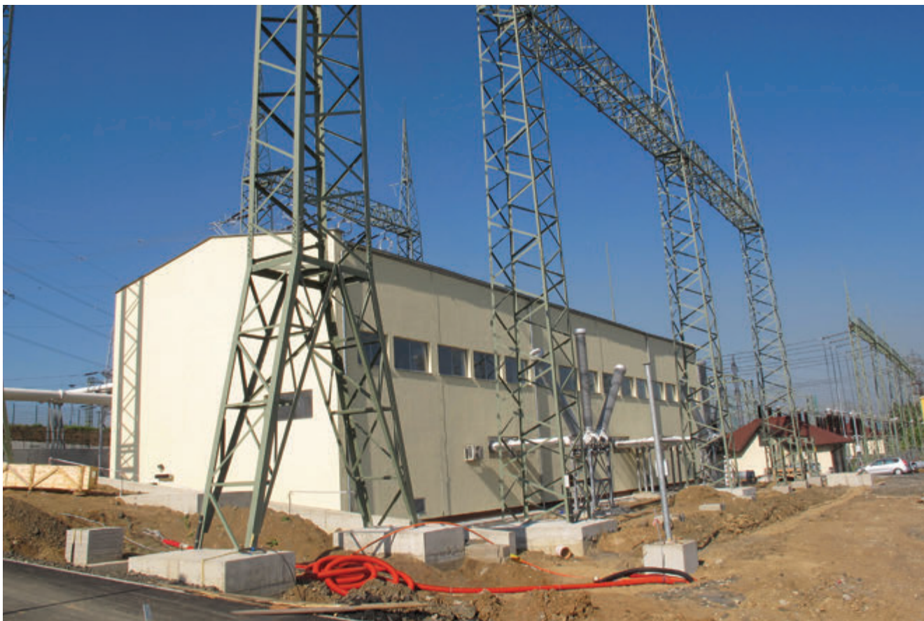
Budova zapouzdřené rozvodny
