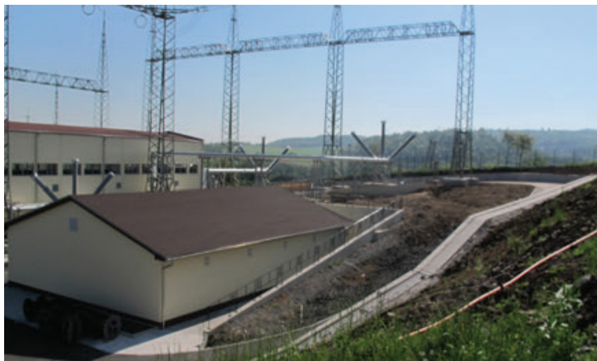
Pohled na stavební objekty
