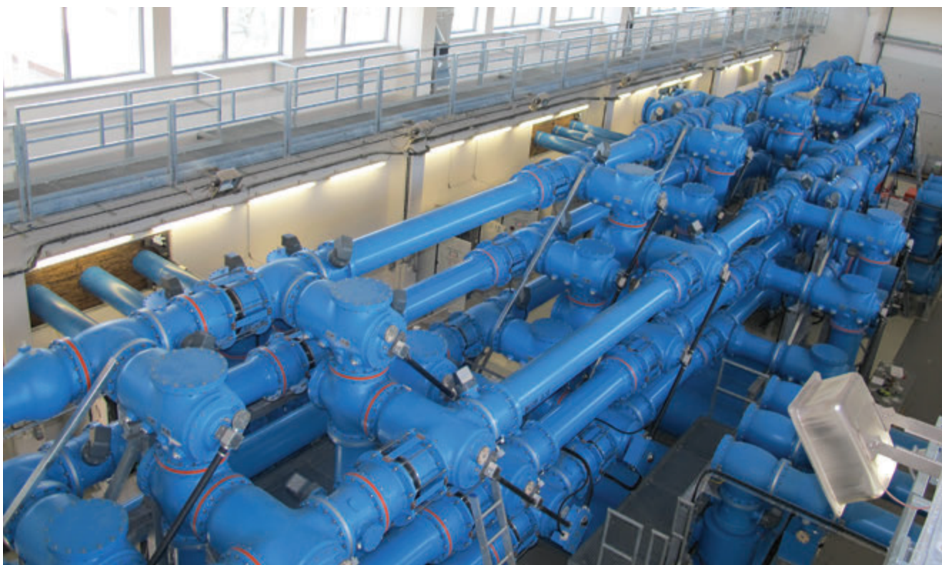
Zapouzdřená rozvodna 420 kV
