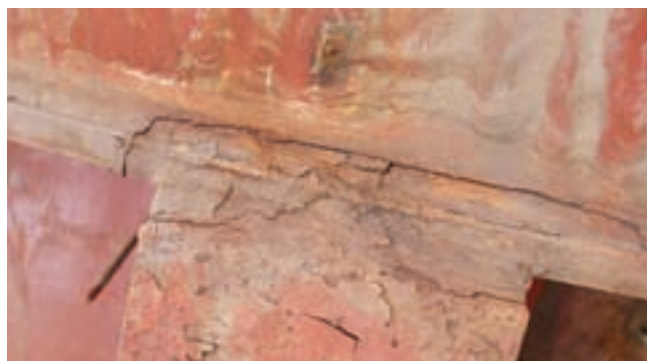
Obr. 9 – Pohled na přechod kuželové a válcové části zvnějška a detail spoje žebra s prstencem
