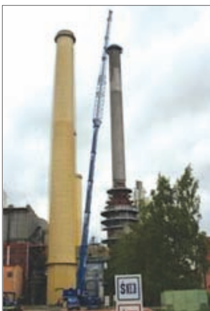
Obr. 15 – Vkládání žebírek do komína
