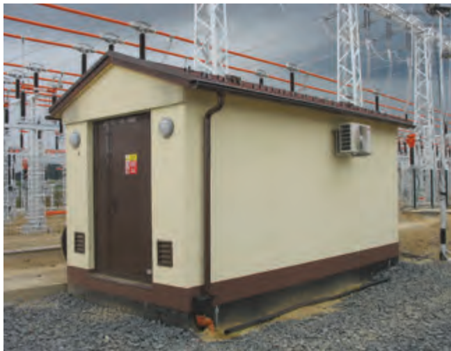
Jeden z domků transformovny
