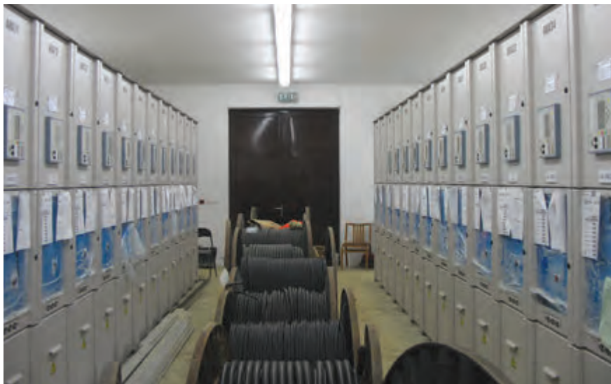
Pohled do rozvodny 22 kV – červenec 2011
