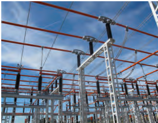
Technologické celky rozvodny
