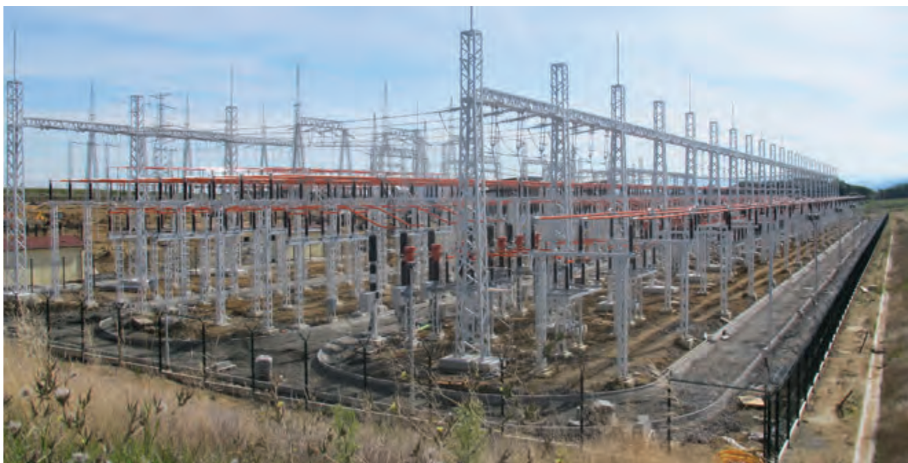
Pohled na transformovnu Kletné
