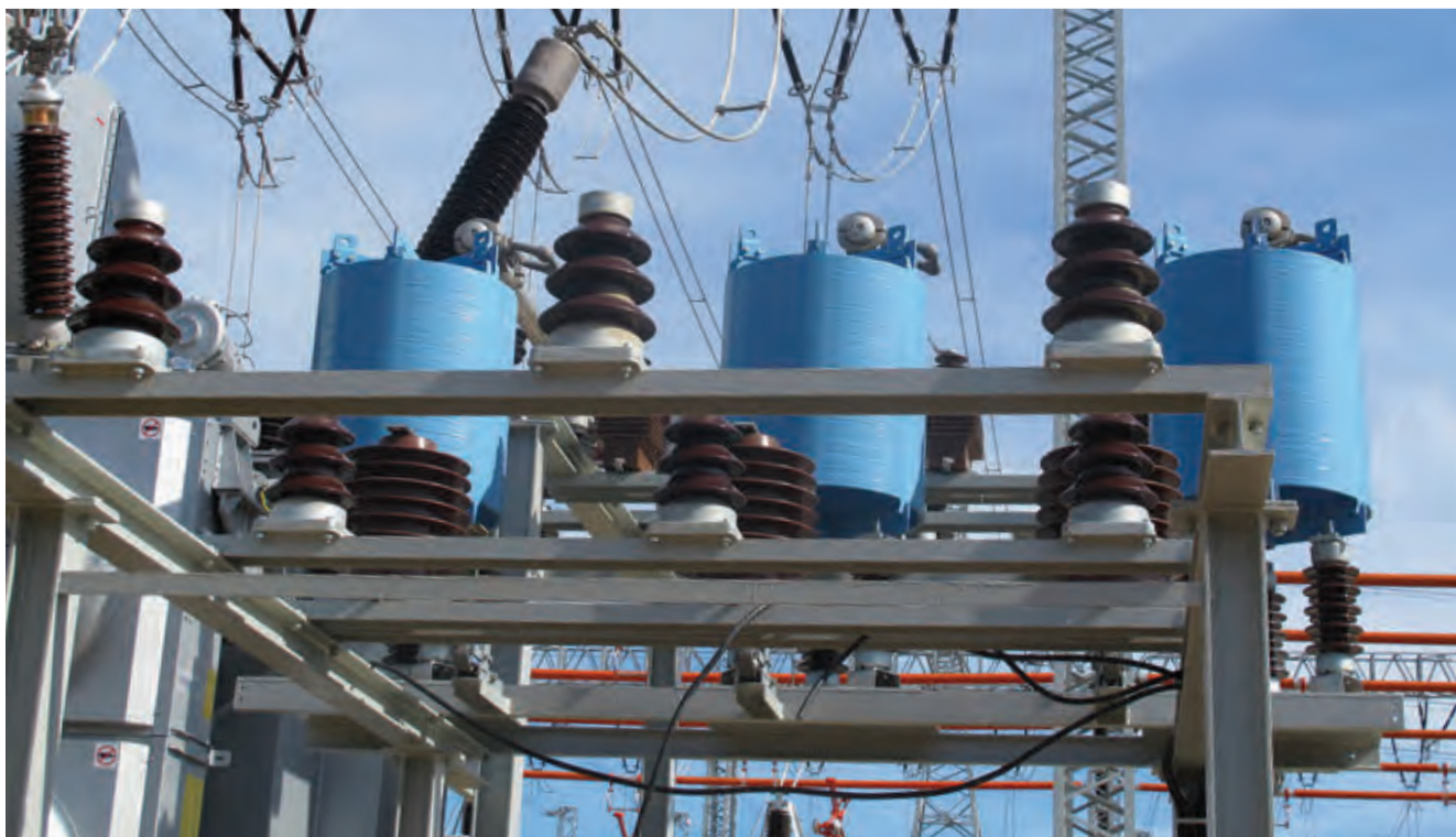
Pohled na část transformovny 110 kV/22 kV
