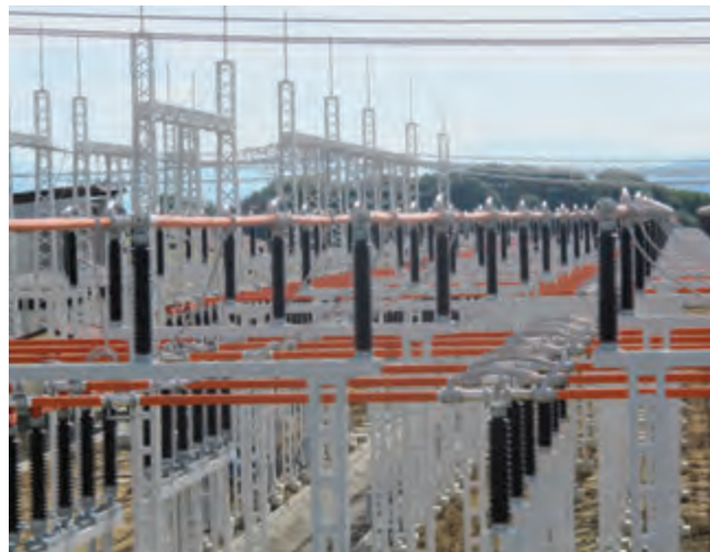
Pohled na zhášecí tlumivky
