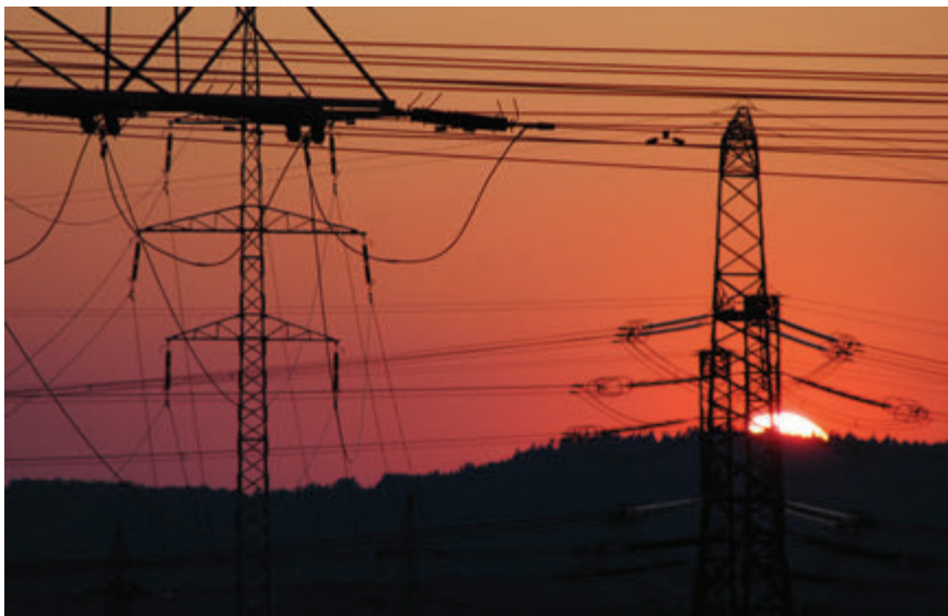
Připojení bloku a zvyšování jeho výkonu má předem daná pravidla a je rozplánováno do jednotlivých hodin - ilustrační foto
