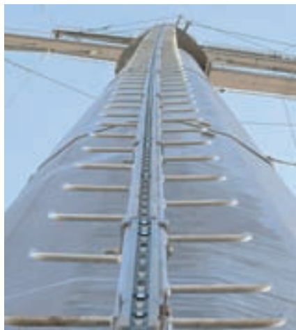
Pohľad z podlahy na napružený driek stožiaru
