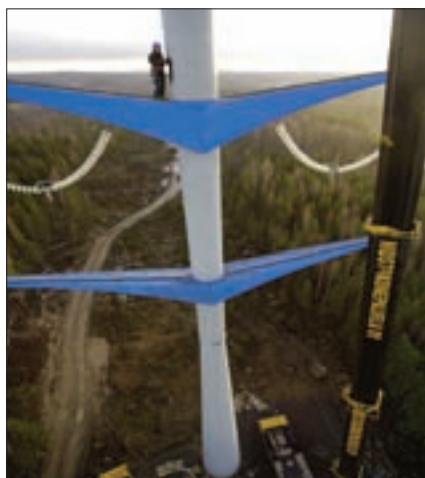
Servisný prístup k izolátorovým závesom je dutým driekom stožiaru
