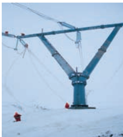
Silový účinok vetra je vidieť z priehybu visiaceho lana smerom ku kľáčickej postave, kde pohyb vo vzpriamej polohe je takmer nemožný
