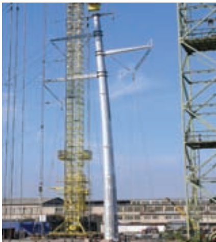
Priehyb stožiaru v oblasti elastickej deformácie bez deštrukcie
