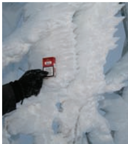
Bežný doplnok ocelevej konštrukcie stožiarov v blízkosti polárneho kruhu
