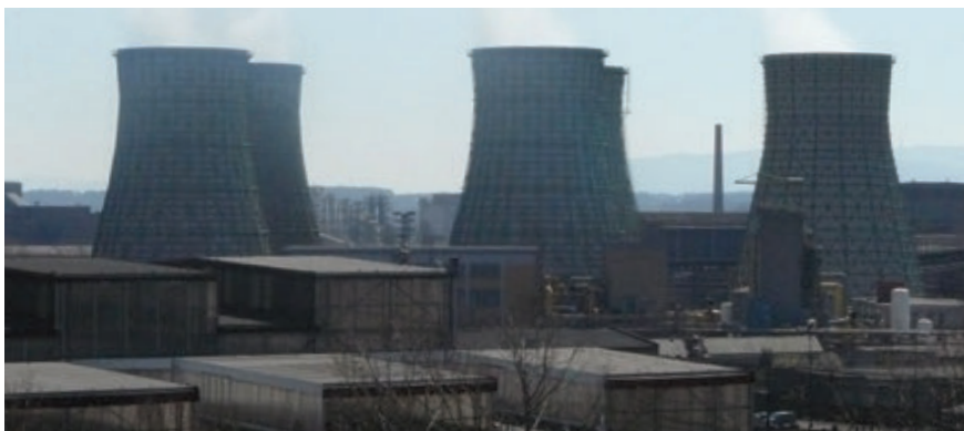
Chladicí věže energetiky v Ostravě
