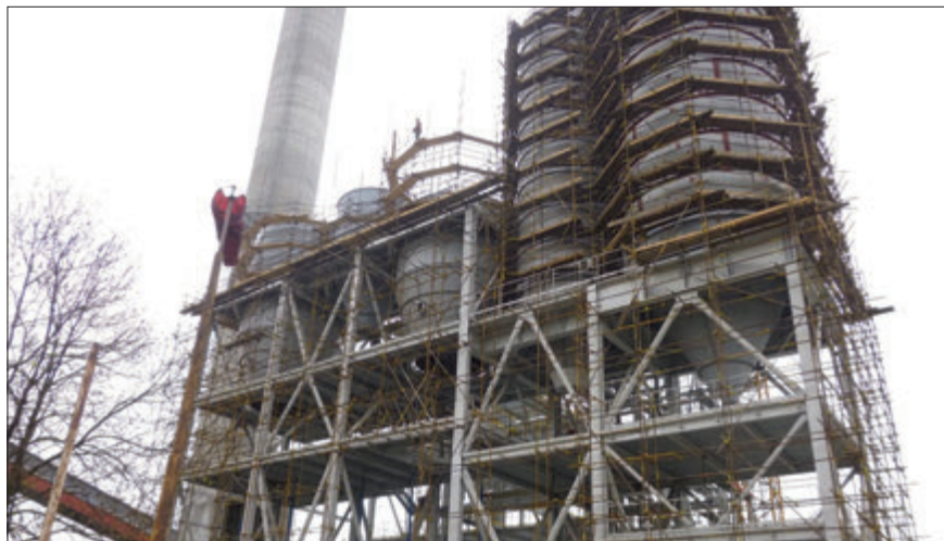
Aktuální stav výstavby odsíření - (květen 2013)
