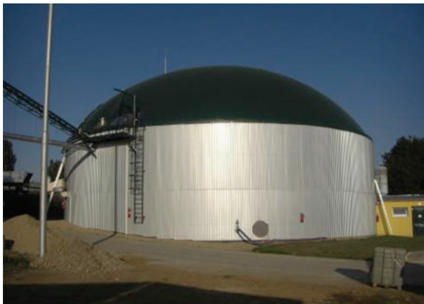
Obr. 1 – Fermentor bioplynové stanice Nový Dvůr (1 970 m 3 , možná roční produkce 4 GWh, zdroj: EPS, s.r.o.)
