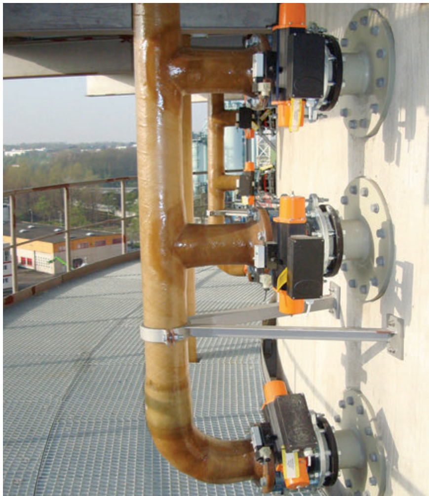
Obr. 3 – Systém procesní vody - přívod k mistelminatoru
