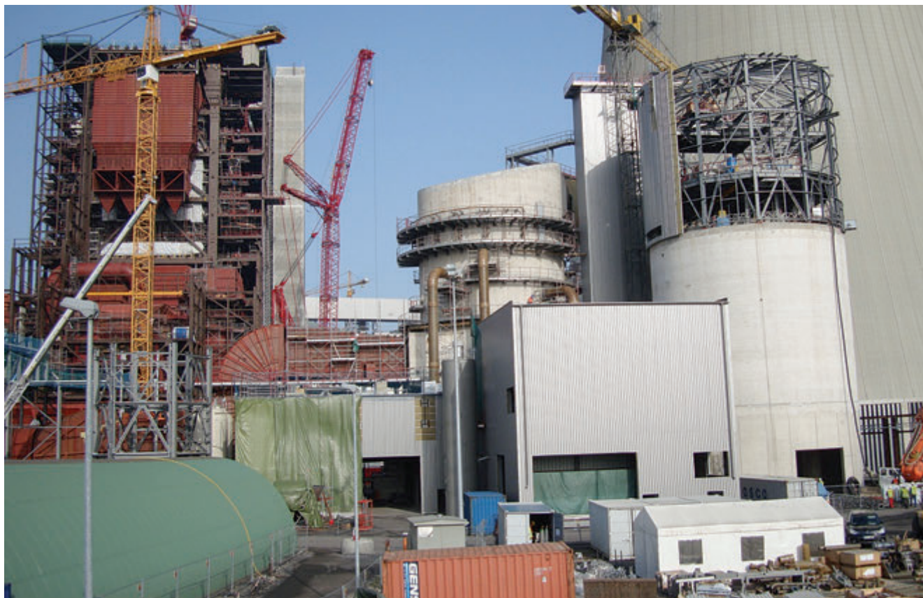
Obr. 1 – Stavba nového zdroje a odsíření
