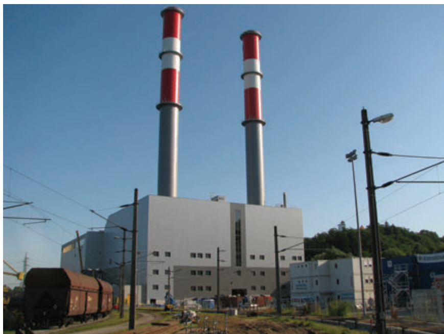
Pohled na elektrárnu Mellach 850 MW
