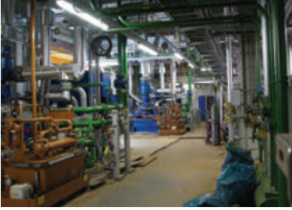
Realizace osvětlení technologie
