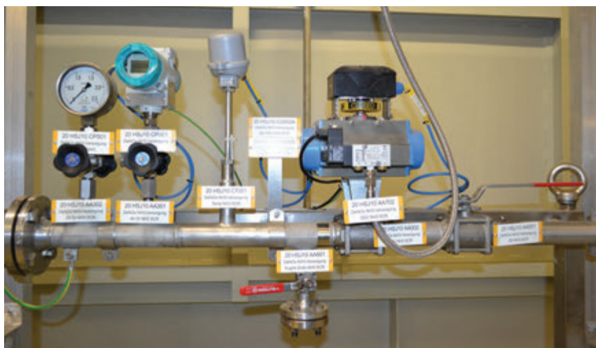
Instalace instrumentace na stavbě - měření
