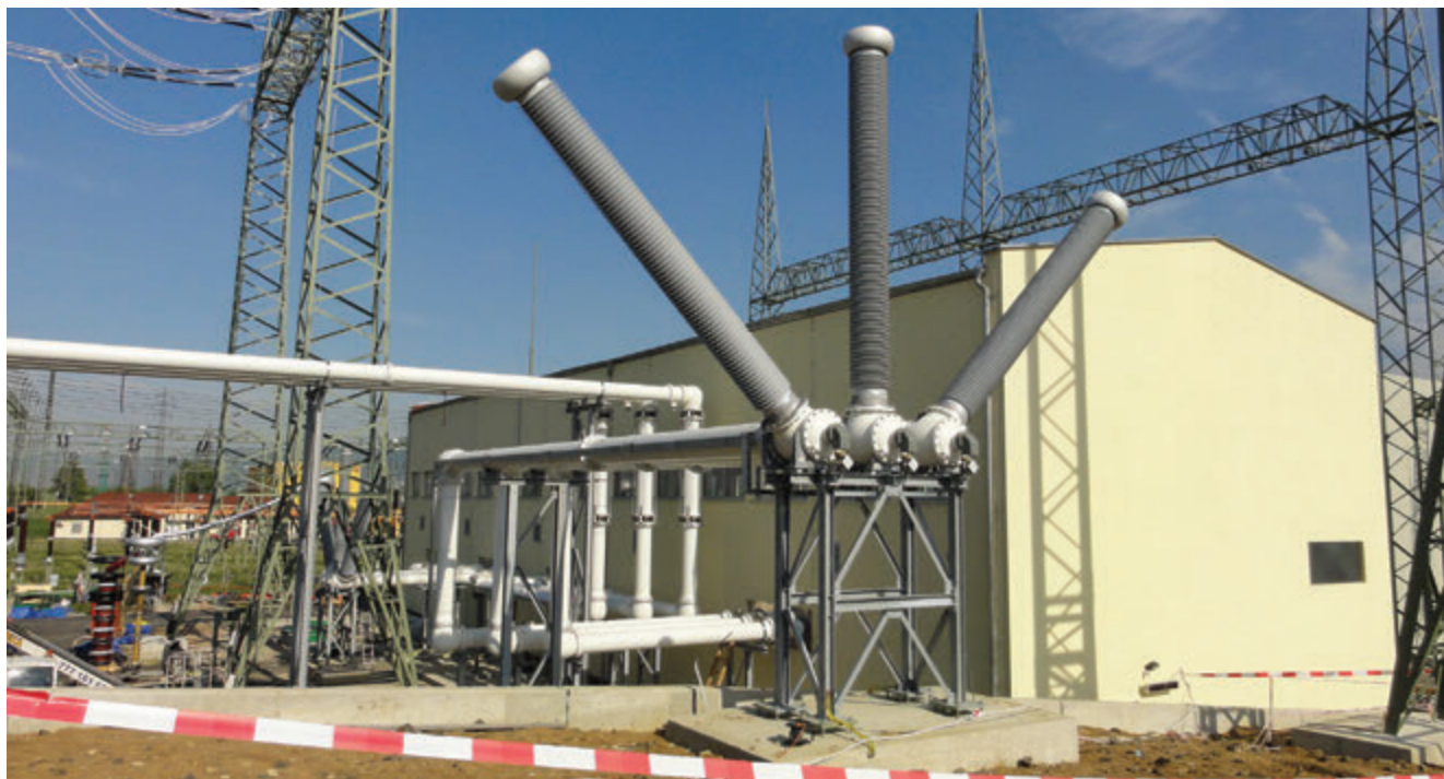
Obr. 3 – Venkovní průchodka 420 kV
