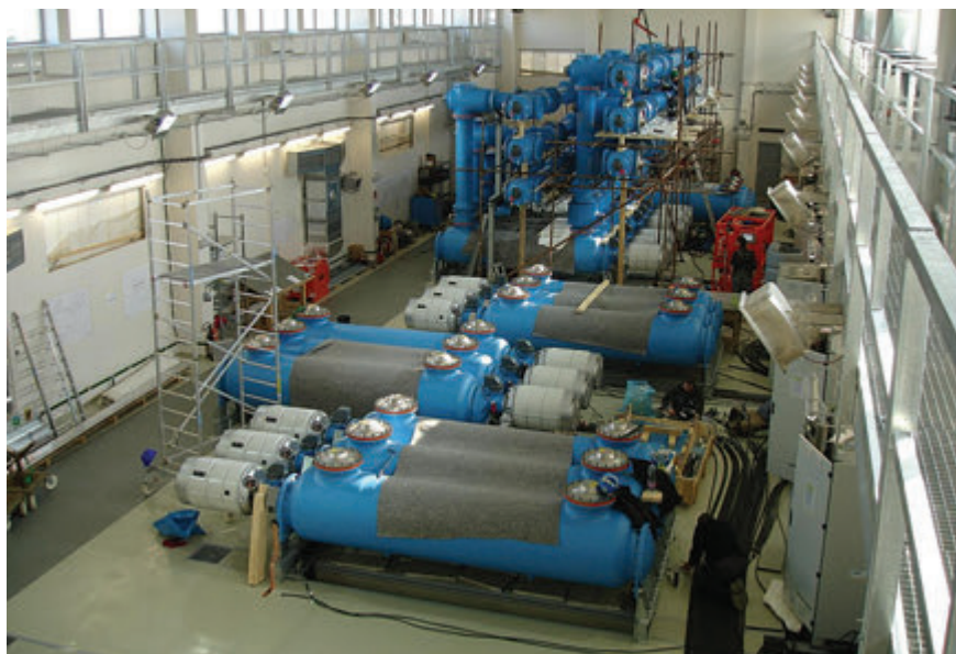
Obr. 5 – Montáž první vrstvy druhé sekce rozváděče
