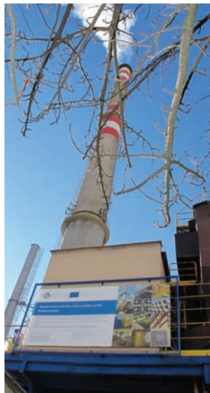
Pohled na teplárnu ve Strakonících
