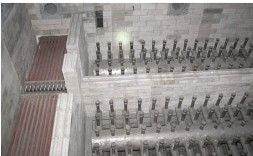
Pohled na topeniště
