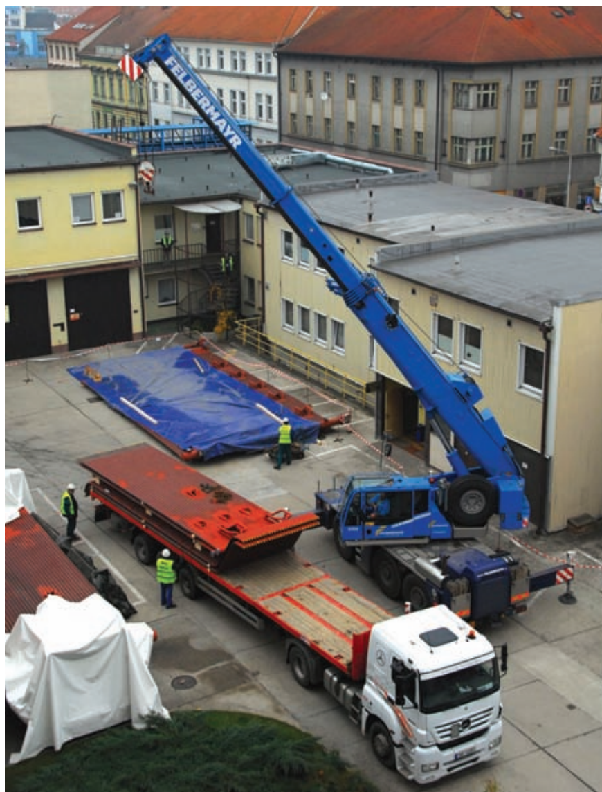
Montáž částí kotle
