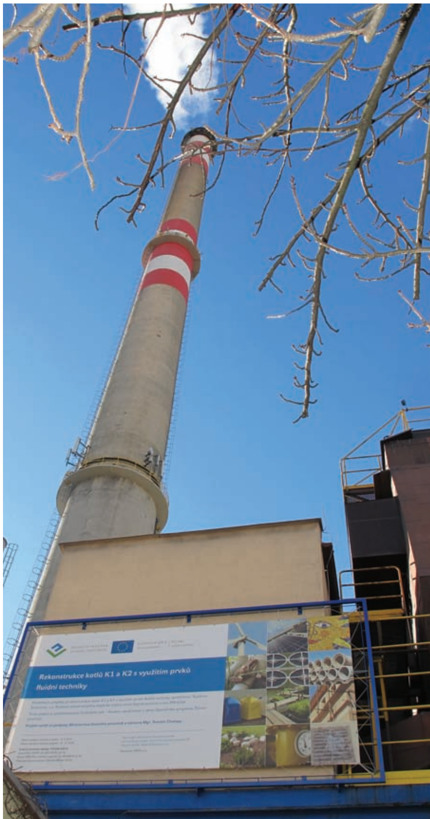
Pohled na teplárnu ve Strakonících
