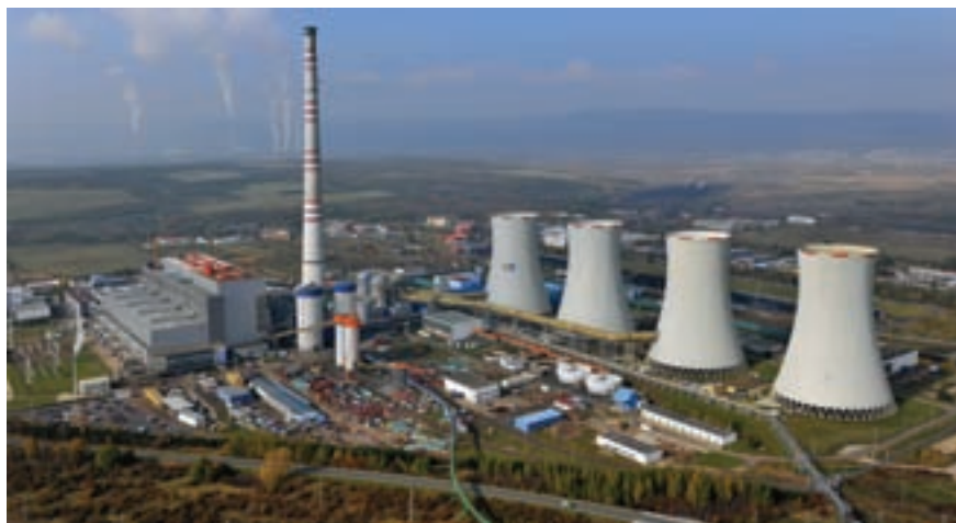
Celkový pohled na ETU II od východu, snímek pořízen v průběhu II. etapy
