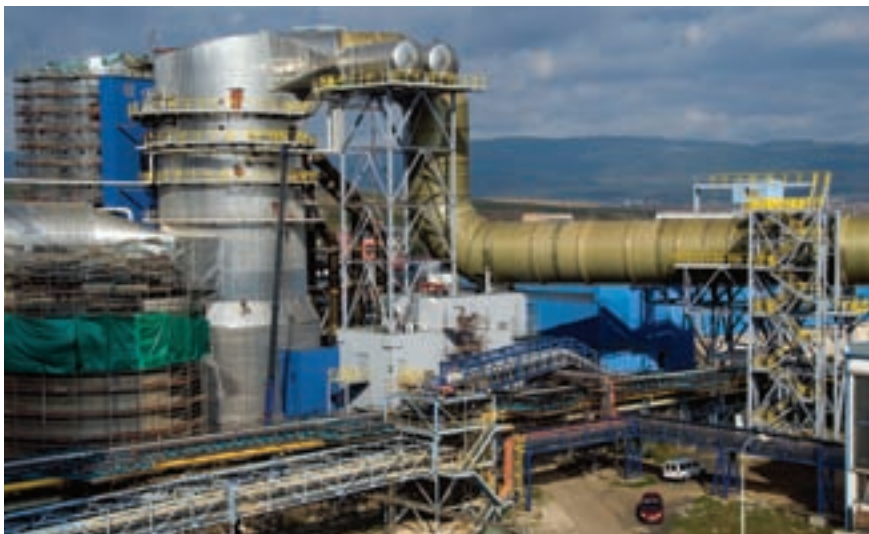
Ústí kouřovodu čistých plynů do absorberu - snímek z realizace I. etapy
