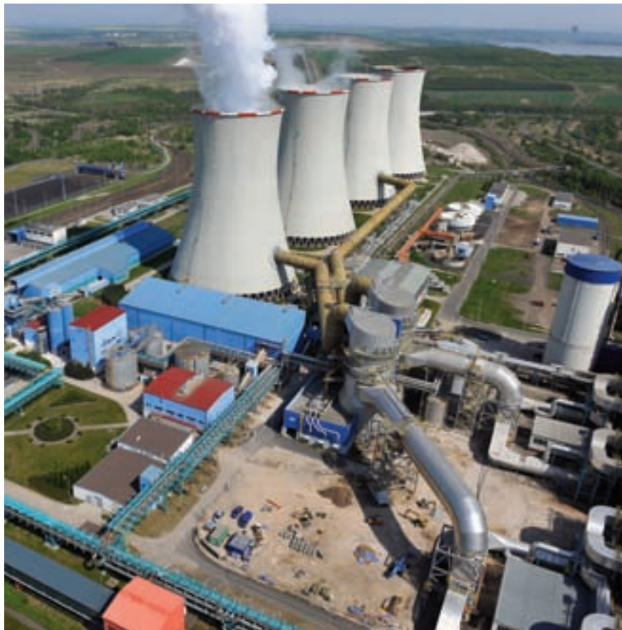
Pohled na některé technologie Elektrárny Tušimice II
