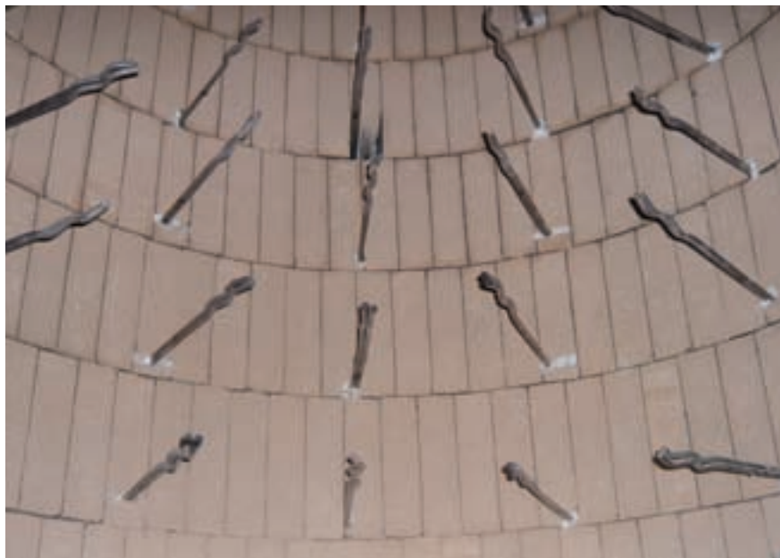
Izolační vrstva s kotvením vyzdívek v části sušící šachty
