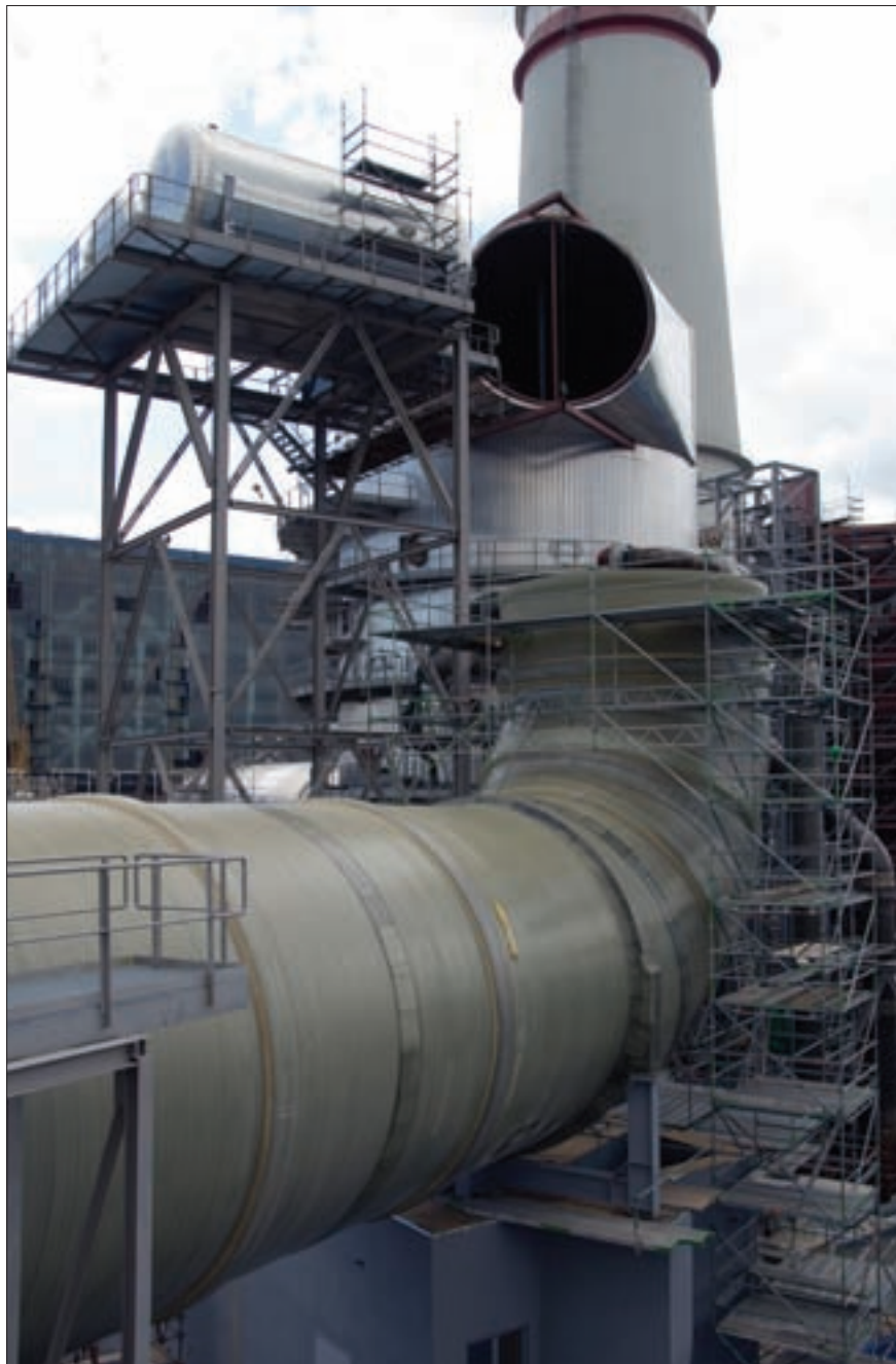
Na snímku kouřovod čistých plynů z absorbérů
