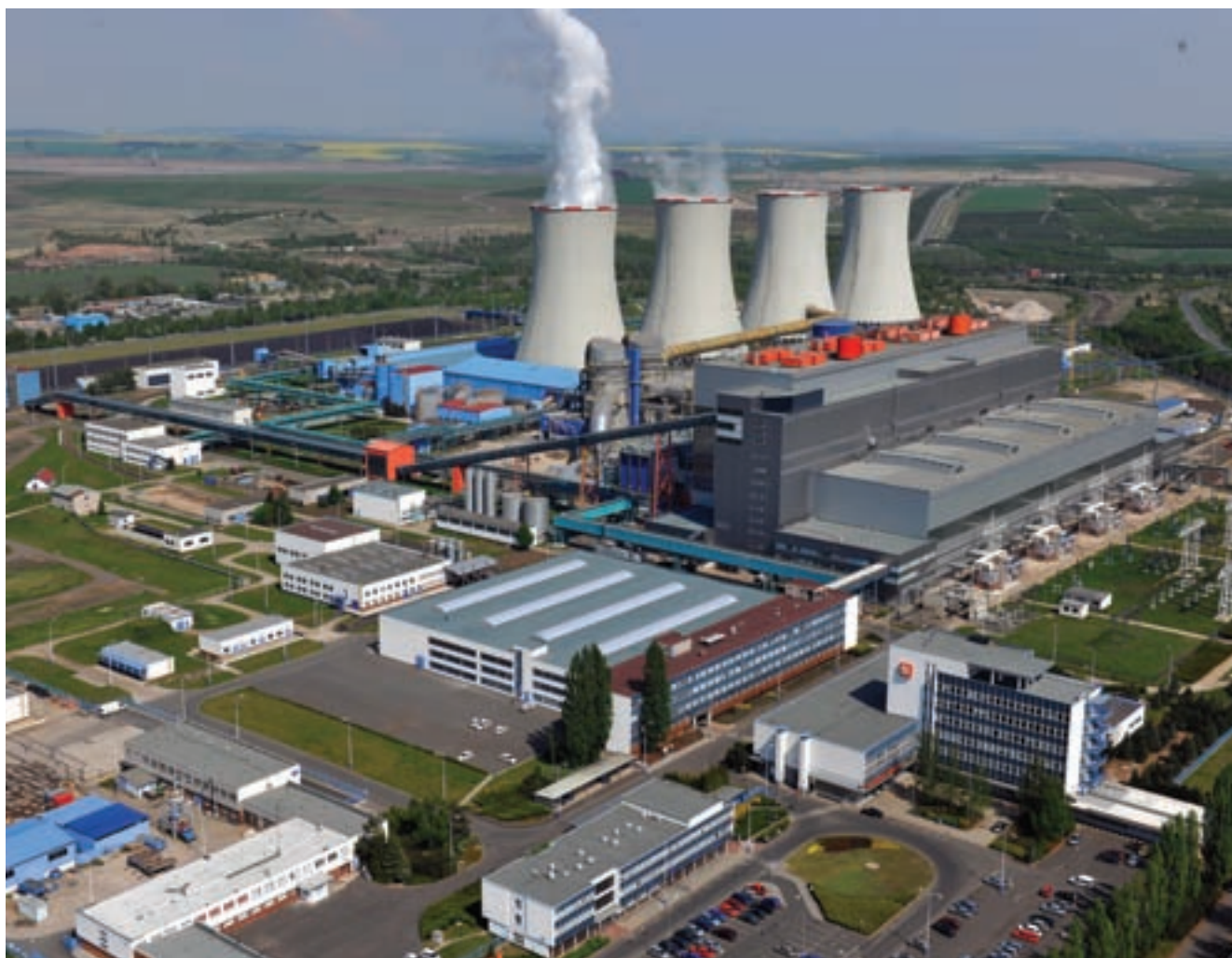
Celkový pohled na Elektrárnu Tušimice II
