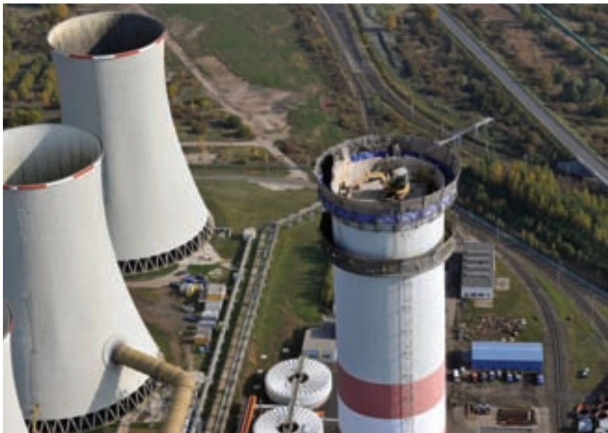
Snímek z demolice komína
