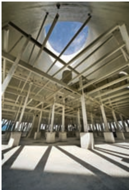
Prefabrikovaná nosná vestavba
