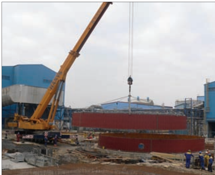
Montáž segmentů absorberu pomocí přípravku
