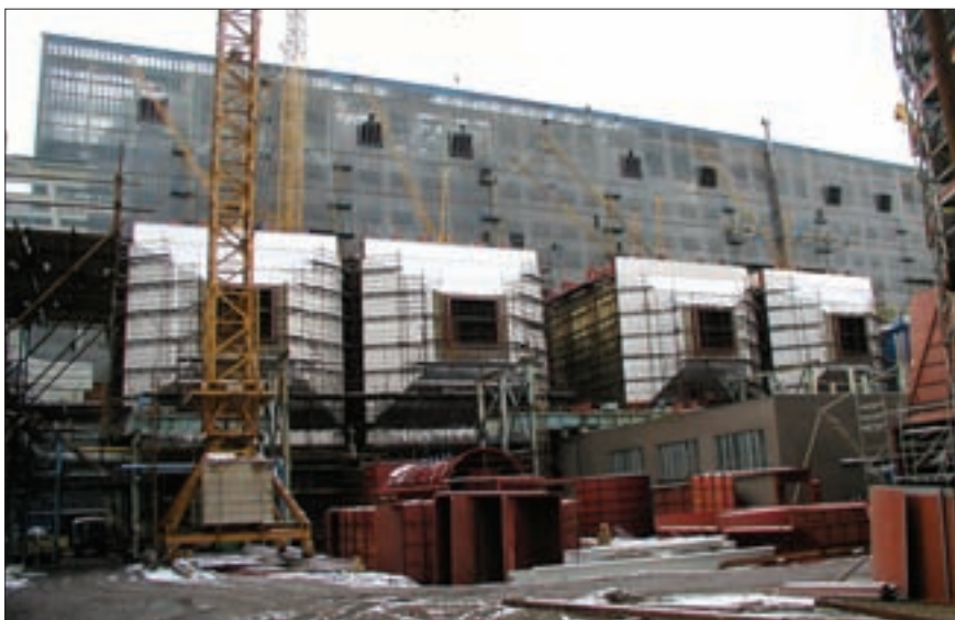
Stav montáže elektroodlučovačů (bloky 23 a 24), snímek z roku 2008
