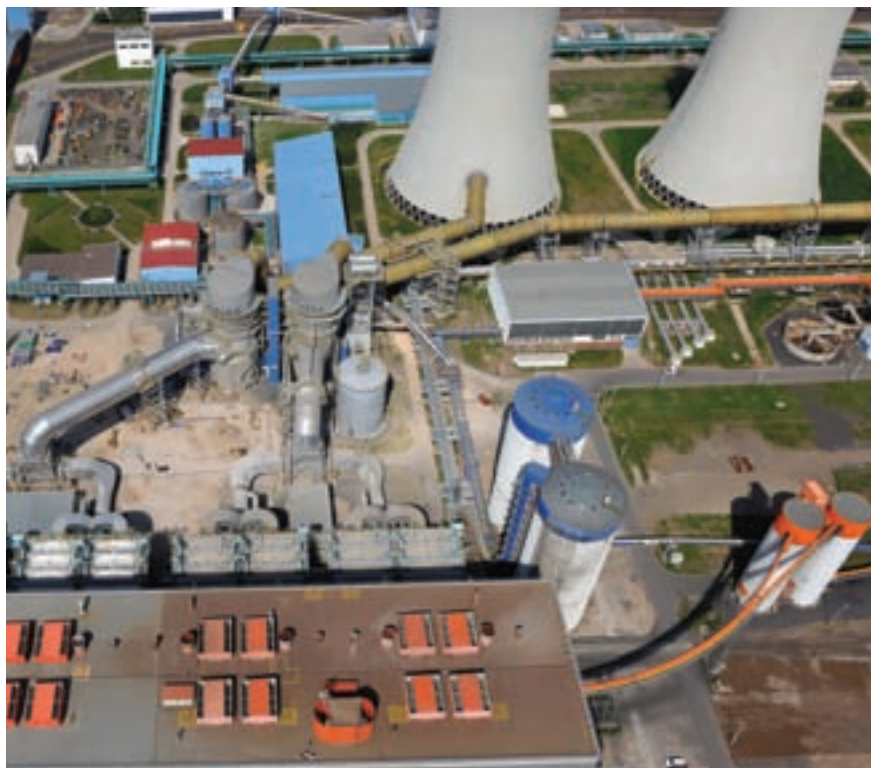
Letecký pohled na Elektrárnu Tušimice II - ilustrační foto
