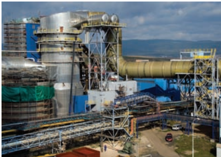
Výstup kouřovodu čistých plynů z absorbérů - snímek z realizace I. etapy
