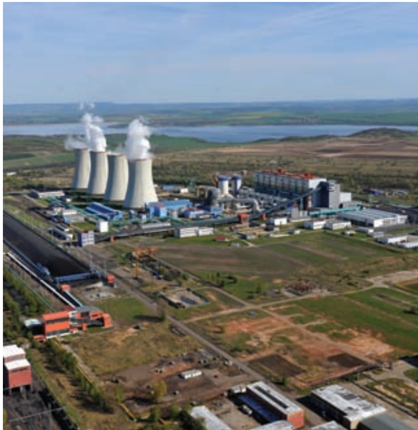
Pohled na Elektrárnu Tušimice II
