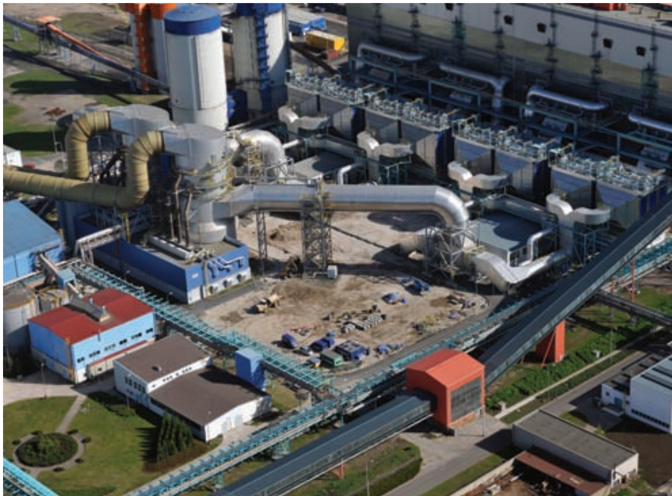
Letecký pohled na část technologií Elektrárny Tušimice II
