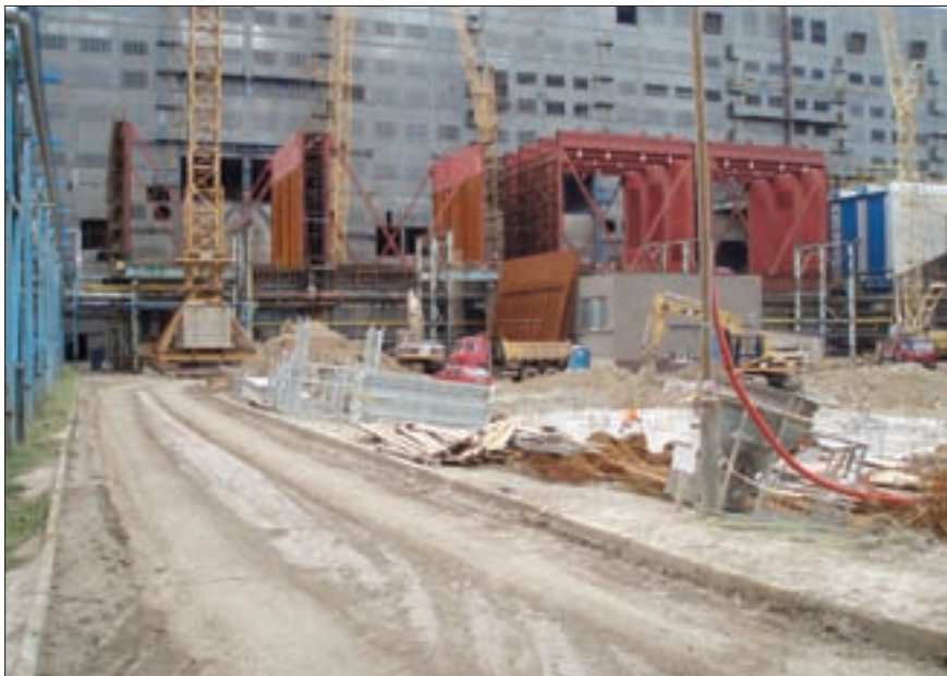
Stav montáže elektroodlučovačů (bloky 23 a 24), snímek z roku 2007
