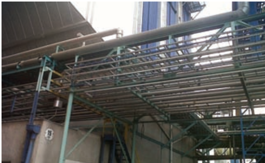
Provizorní kabelové trasy přeložené mimo kabelové kanály na most mezi elektro odlučovači
