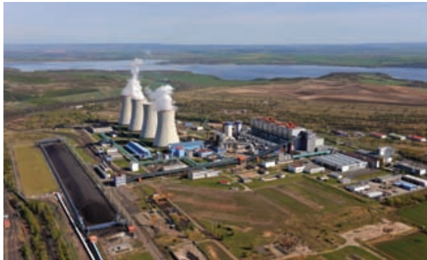
Letecký pohled na Elektrárnu Tušimice po skončení obnovy
