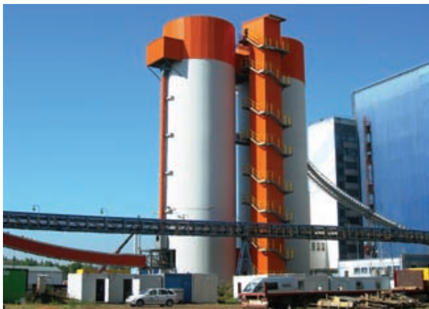
Pohled na silu a schodišťovou věž
