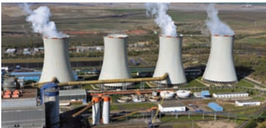
Pohled na Elektrárnu Tušimice II
