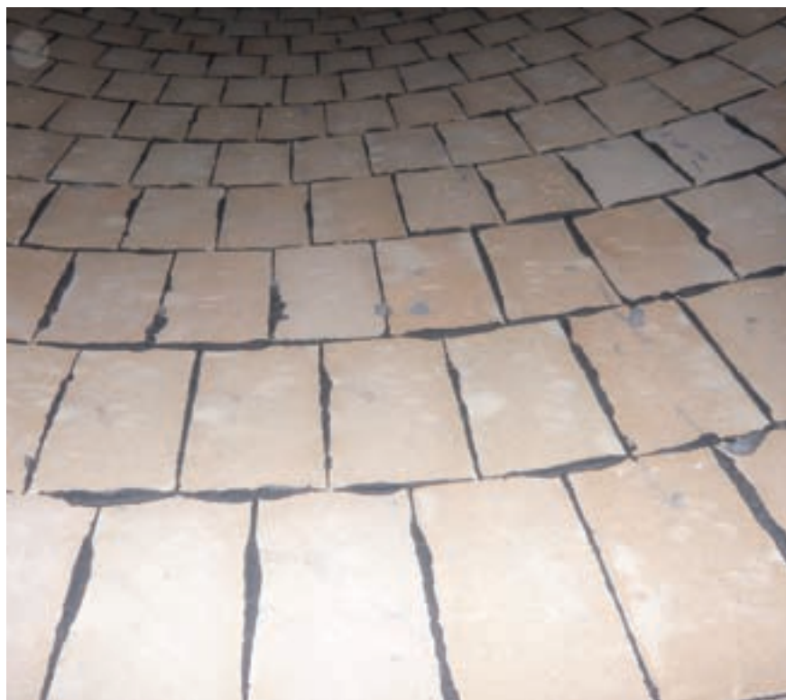
Vyzdívková izolační vrstva v sušící šachtě
