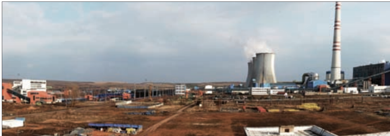
Panoramatický snímek staveniště
