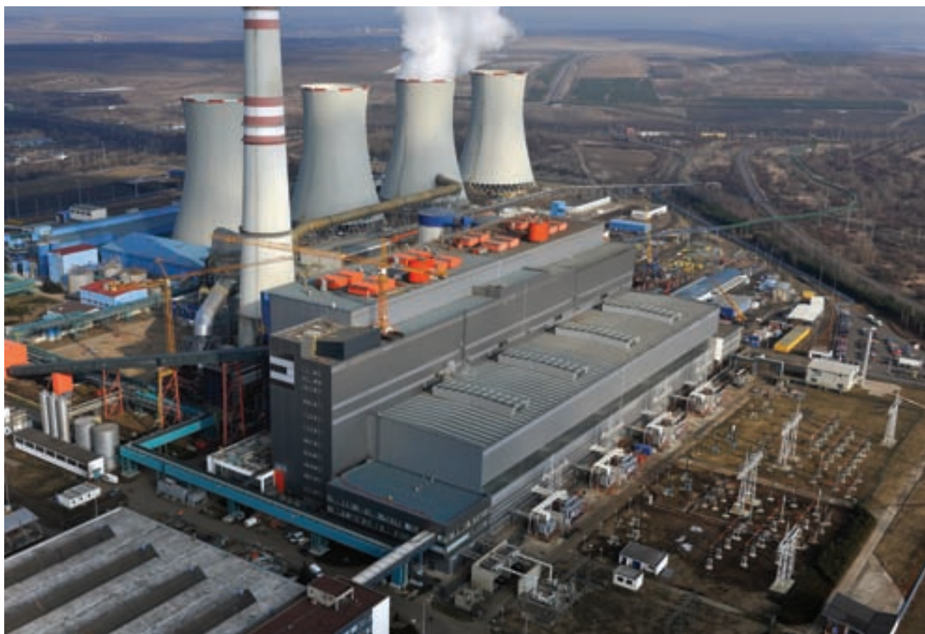
Nové, architektonicky velmi zdařilé, opláštění hlavního výrobního bloku
