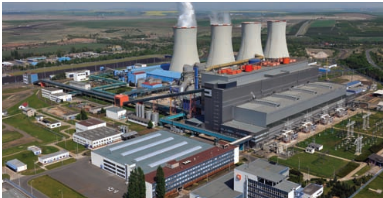
Letecký pohled na Elektrárnu Tušimice
