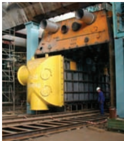
Zasouvání nového trubkového modulu kondenzátoru
