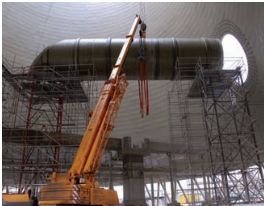
Montáž vyvedení spalin uvnitř chladicí věže
