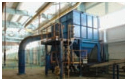
Odsávací zařízení pásů
