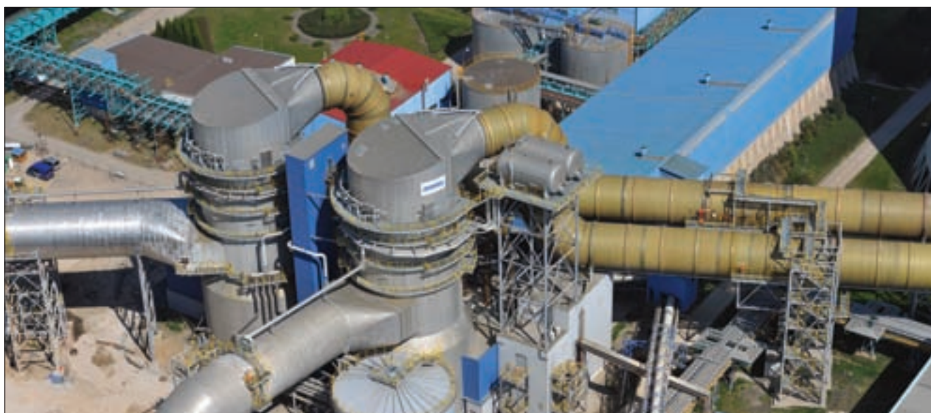
Pohled na Elektrárnu Tušimice II
