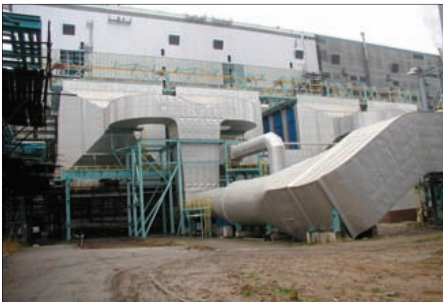
Ukončení montáže elektrických odlučovačů a spalínových ventilátorů KO ETU II, I. etapa (bloky 23, 24)
