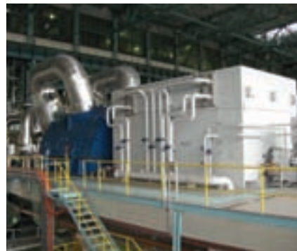
Turbosoustrojí - foto od generátoru
