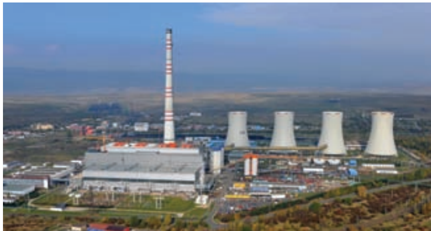
Celkový pohled na ETU II z jižní strany, snímek pořízen v průběhu II. etapy
