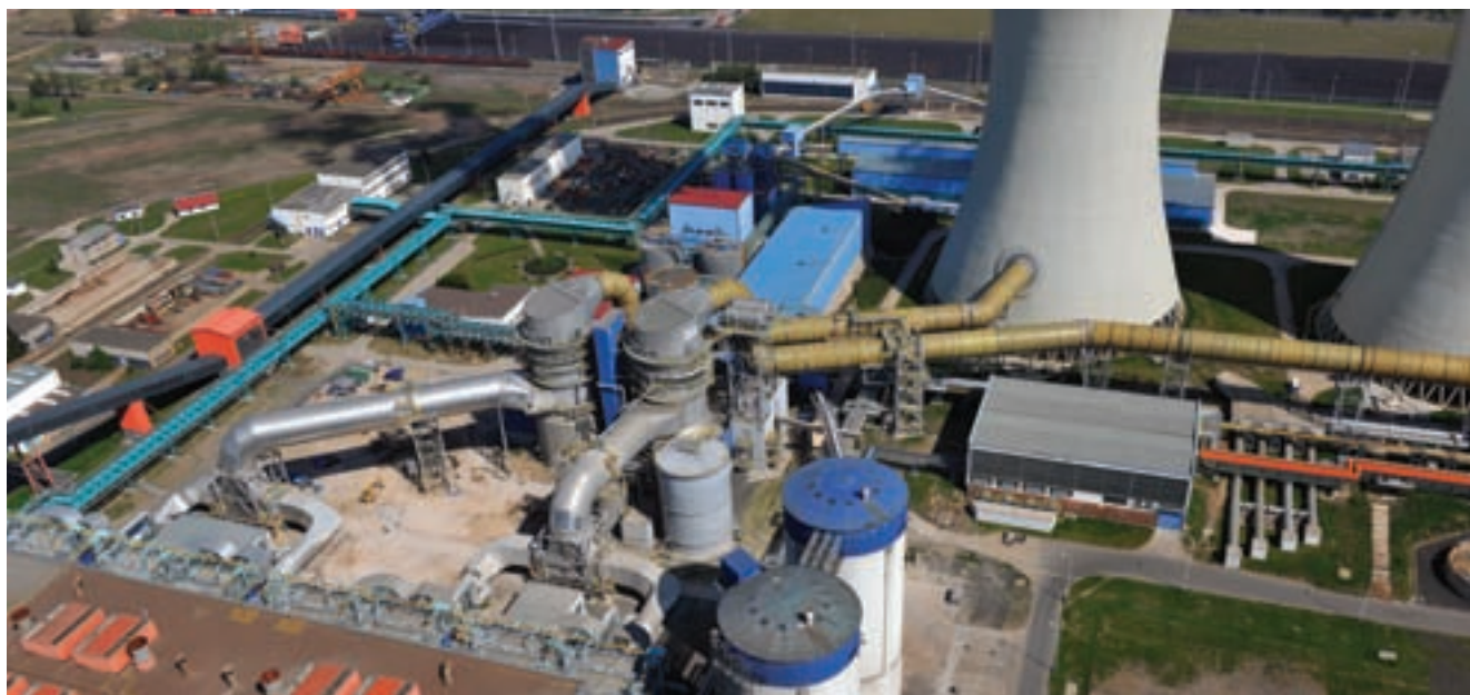
Letecký pohled na technologii Elektrárny Tušimice II
