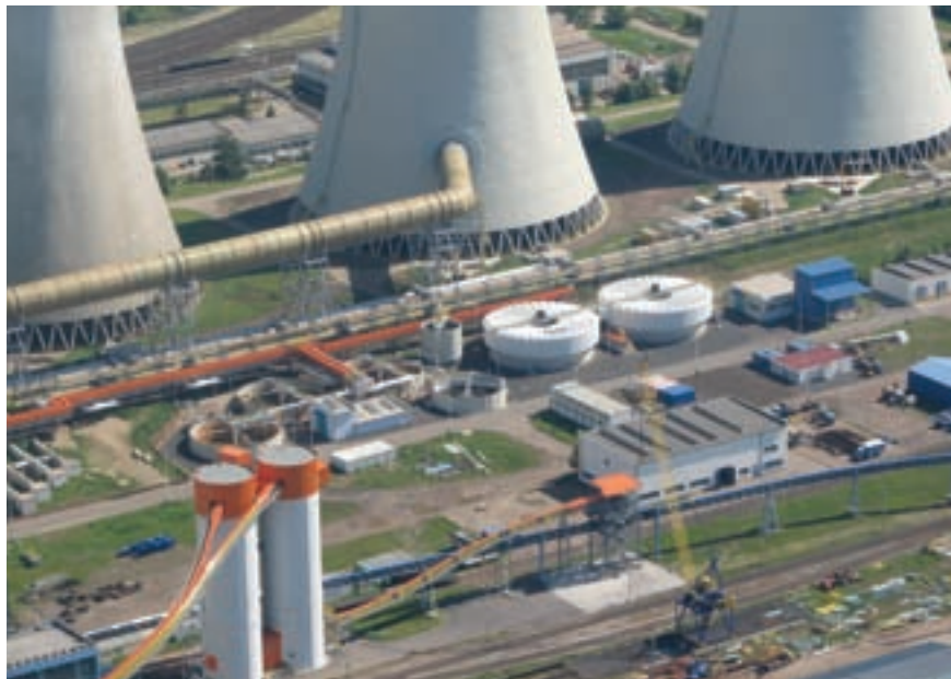
Letecký pohled na staveniště Elektrárny Tušimice II
