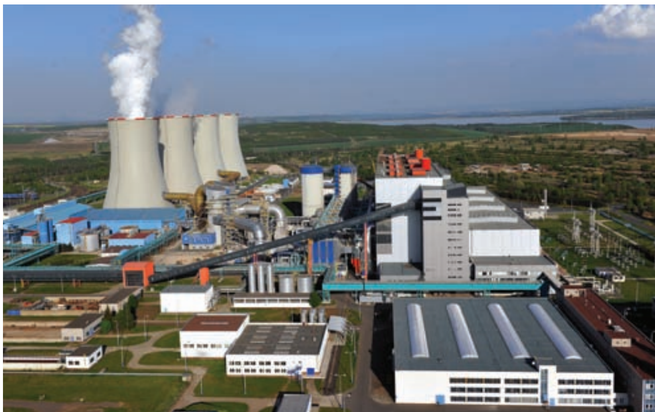
Letecký pohled na Elektrárnu Tušimice II
