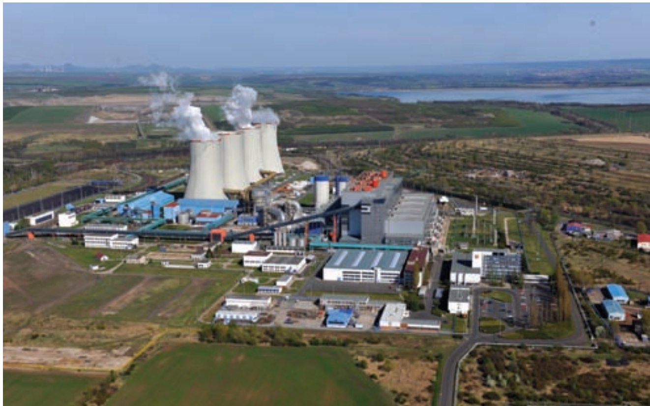
Letecký pohled na elektrárnu po rekonstrukci
