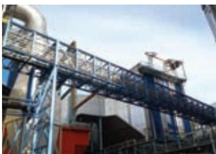
Provizorní kabelové trasy přeložené mimo kabelové kanály na most vybudovaný v rámci provizoria č. 73
