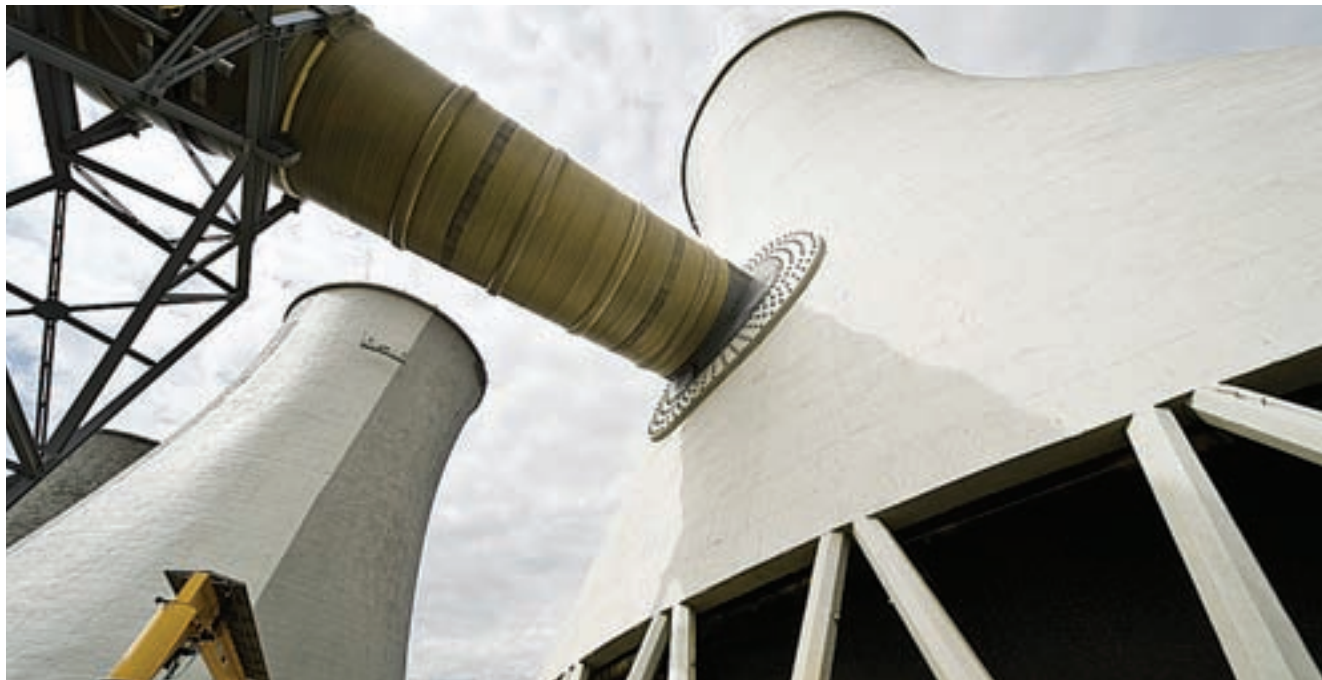
Sanace vnějších plášťů
