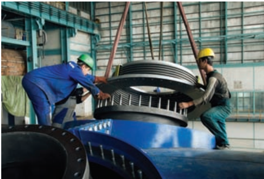
Montáž kompenzátoru na nízkotlaké těleso
