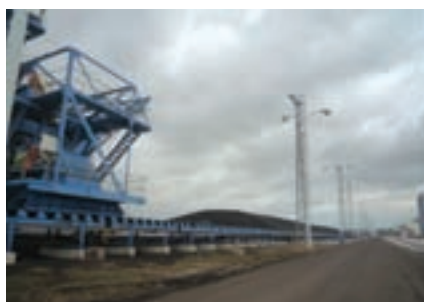
24 metrů vysoké stožáry pro osvětlení skládky zauhlování
