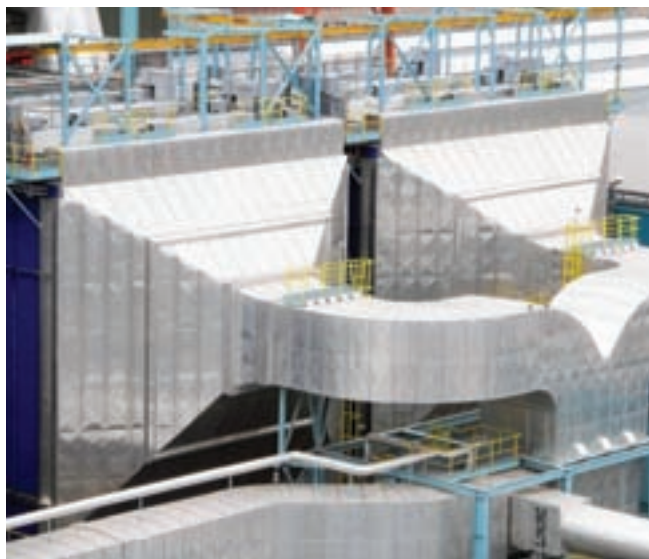
Snímky tepelné izolace elektroodlučovače boků 21 a 22
