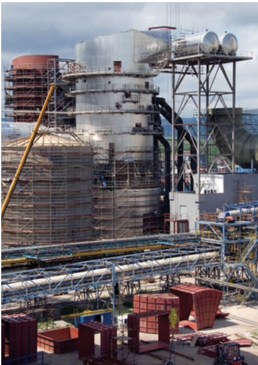
Absorbér a vypouštěcí jímka - snímek z realizace I. etapy
