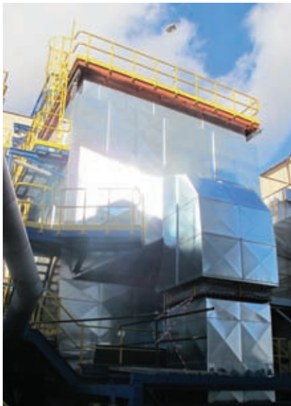
Elektrostatický odlučovač TZL
