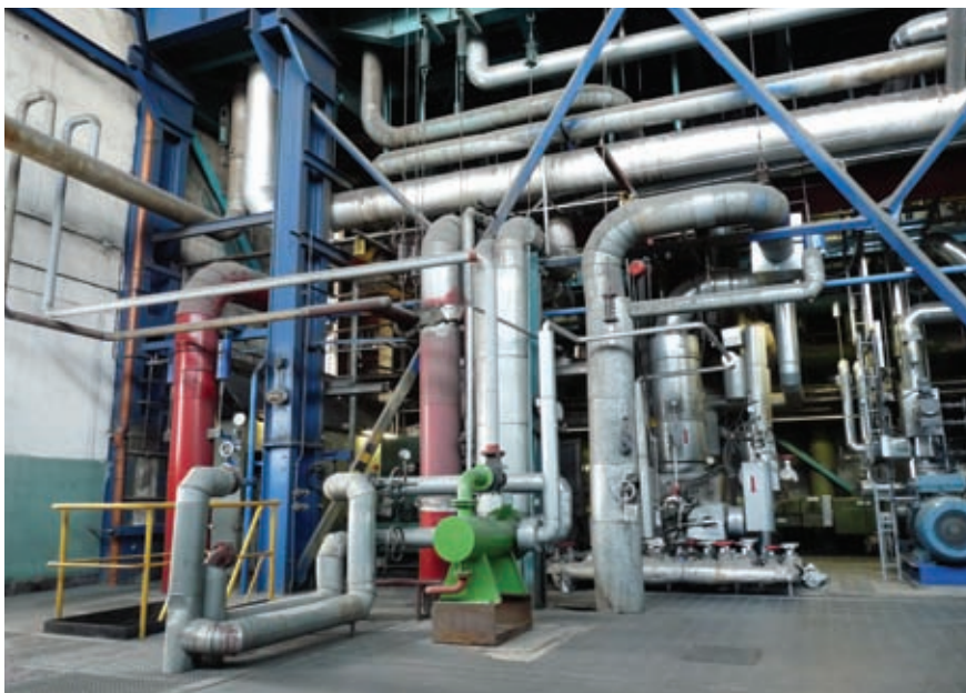
Napájecí čerpadla
