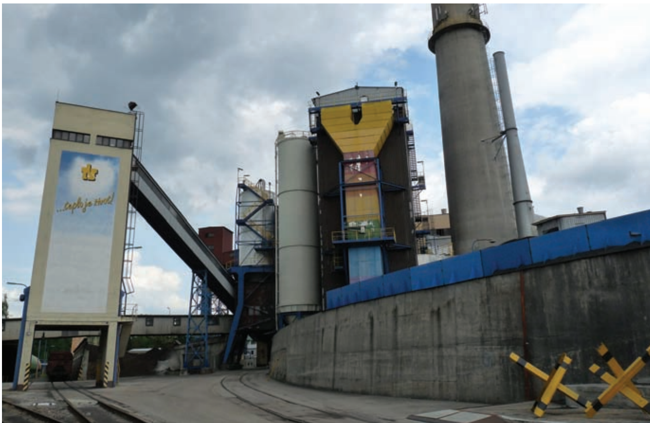
Pohled na teplárnu
