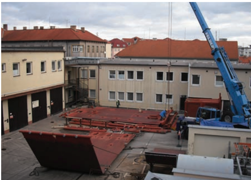
Montáž membránových stěn
