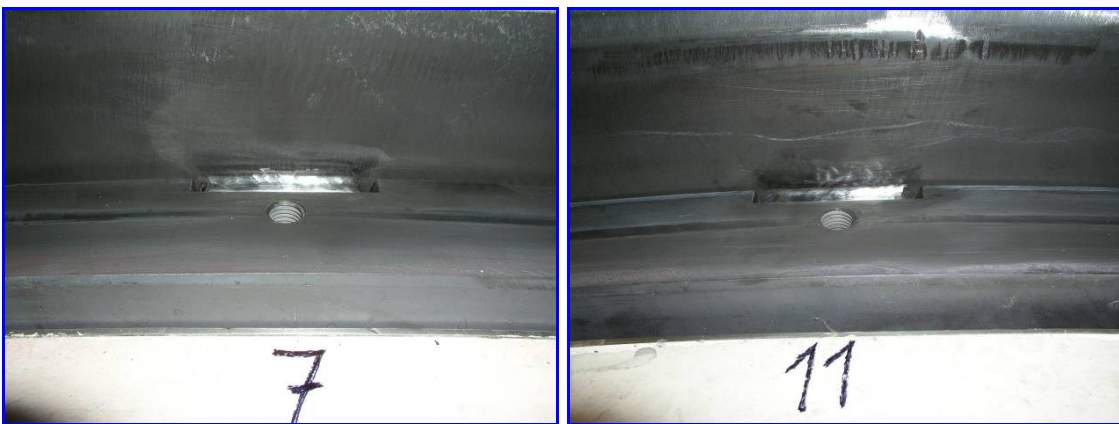
Obr. 10 Vizuální kontrola vystředění šachty reaktoru po opravě per č. 7 a 11 [2]
