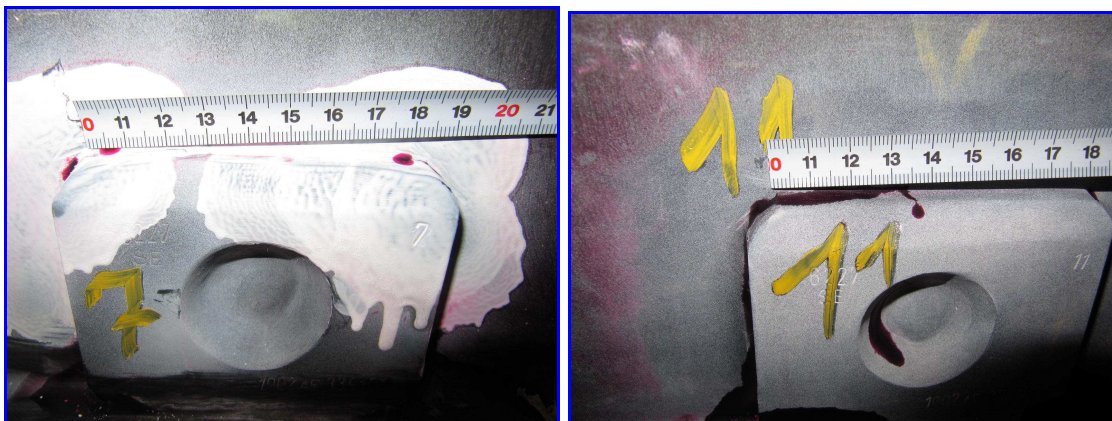
Obr. 7 Penetrační kontrola per č. 7 a 11 před opravou [2]
