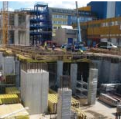
Průběh výstavby a montáže bednění stropu kotelny
