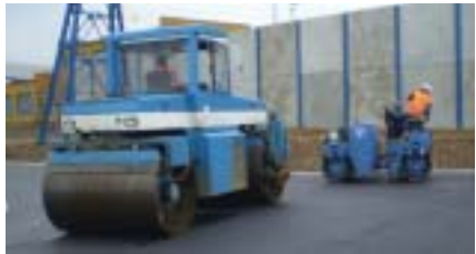
Pokládka živičných povrchů komunikace v lokalitě nového zauhlování
