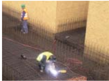
Montáž výztuže v potrubním a kabelovém kolektoru
