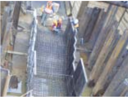
Montáž výztuže v kabelovém kanálu k drtárně
