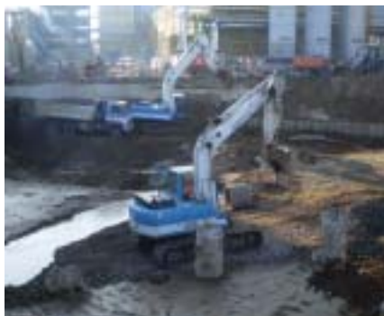
Prostor budoucí čerpací stanice chladicí vody
