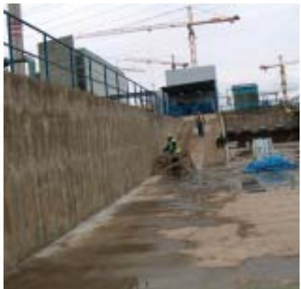
Sanace nádrží na objektu likvidace odpadních vod
