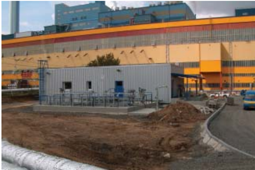
Biologická čistírna odpadních vod - dokončený objekt
