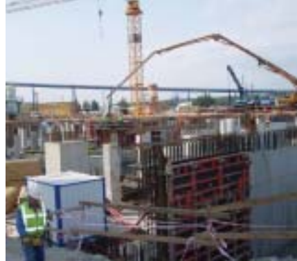
Betonáž spodní stavby kotelny
