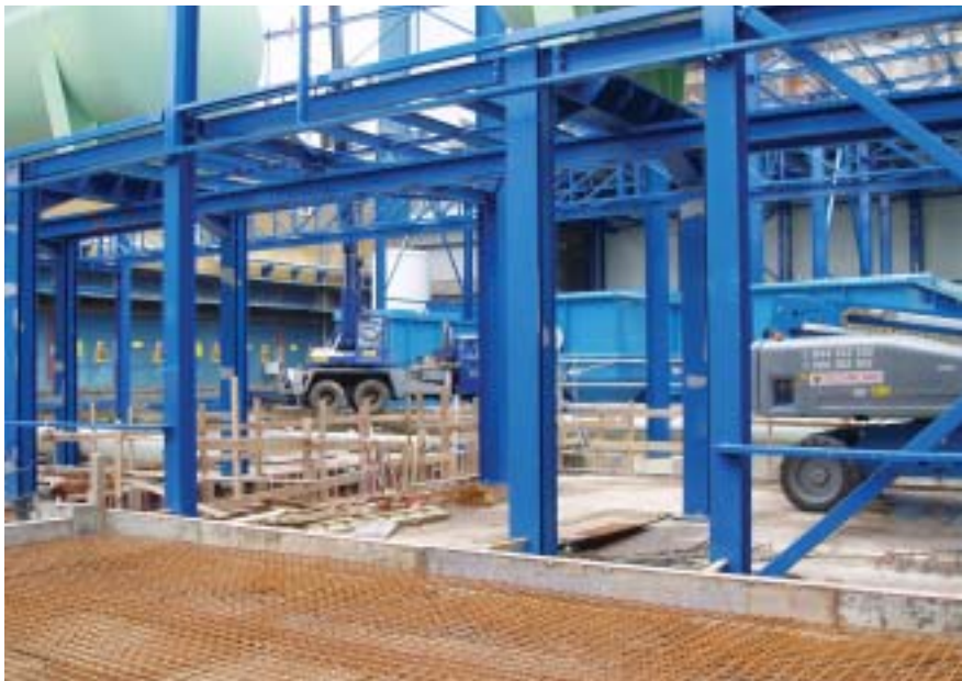
Ocelová konstrukce CHÚV
