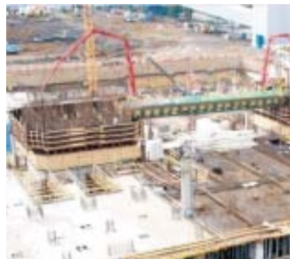
Betonáž spodní části věží
